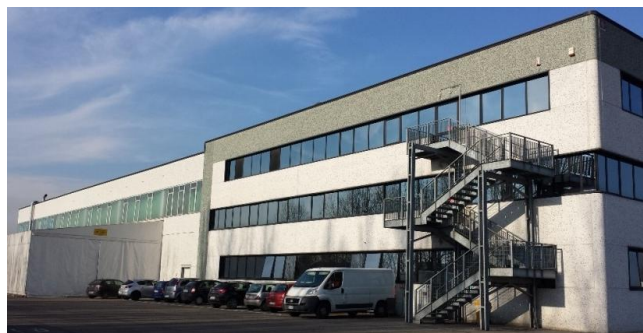
Figura 4. Vista lotto 4 con scala antincendio e lotto 3 con struttura leggera indipendente (prospetto sud-ovest).
