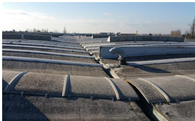
Figura 8. Vista della copertura - zona industriale.
