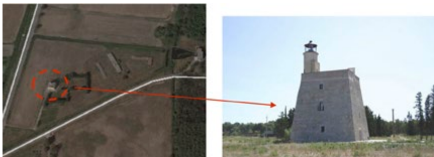
Fig.12. Torre Faro (Scanzano Jonico)
