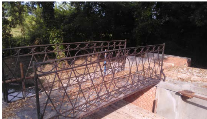
Canale della Corsa, Darsena Meridionale: la passerella in ferro dopo l'intervento di consolidamento e restauro.
