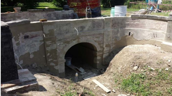
Canale delle Pavoniere, ponte frontistante la Casa del Guardia: fase del recupero, in evidenza i canali ancora in vista utilizzati per le iniezioni di malta.
