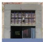
cornici in pietra arenaria
