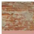
porzioni di muratura in laterizio a vista
