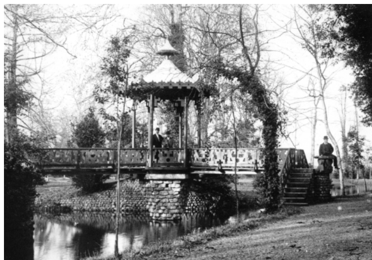
Ponte dell'Ombrellino o dei Tre Rami, realizzato nel 1825-26, oggi si conserva allo stato di rudere solo la pila centrale.
