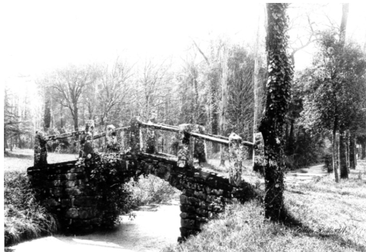
Ponte in Pietra ad arco misto, pillori di fiume e laterizio realizzato nel periodo 1824-29, oggi allo stato di rudere.
