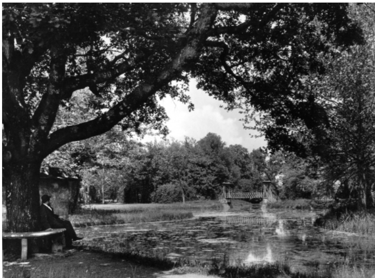
Ponte delle Funi o di Fil di Ferro, ponte sospeso realizzato nel 1826, oggi in stato di rudere.
