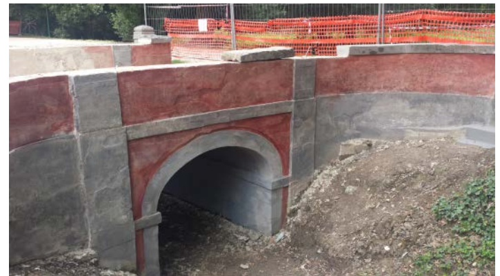
Canale delle Pavoniere, secondo ingresso al Parco: già nella prima fase del cantiere vengono messi all'evidenza elementi nascosti dalla vegetazione infestante.
