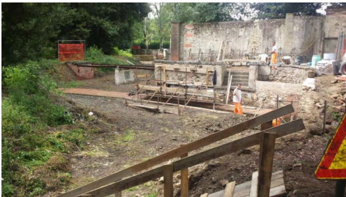
Canale delle Pavoniere, ponte frontistante la Casa del Guardia: fase finale del recupero, prima fase del tinteggio (il manufatto è in attesa della patinatura finale).
