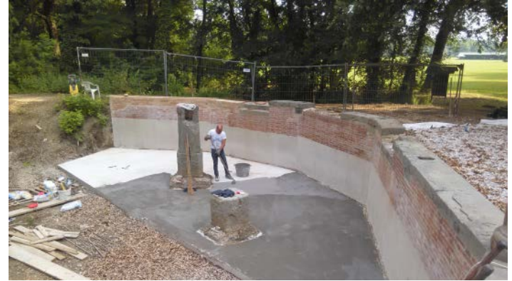
Canale della Corsa, Darsena Meridionale: l'attracco delle barche durante le operazioni preparatorie alla ripavimentazione del fondo del canale.
