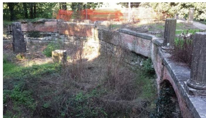
Canale della Corsa, Darsena Meridionale: l'attracco delle barche nella fase immediatamente precedente all'intervento di recupero.
