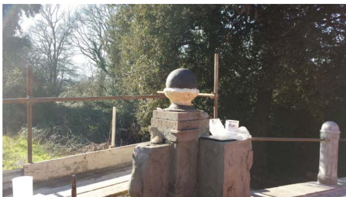
Canale della Corsa, Ponte alla Curva: angolare del parapetto con sfera in resina viene durante il rifacimento.
