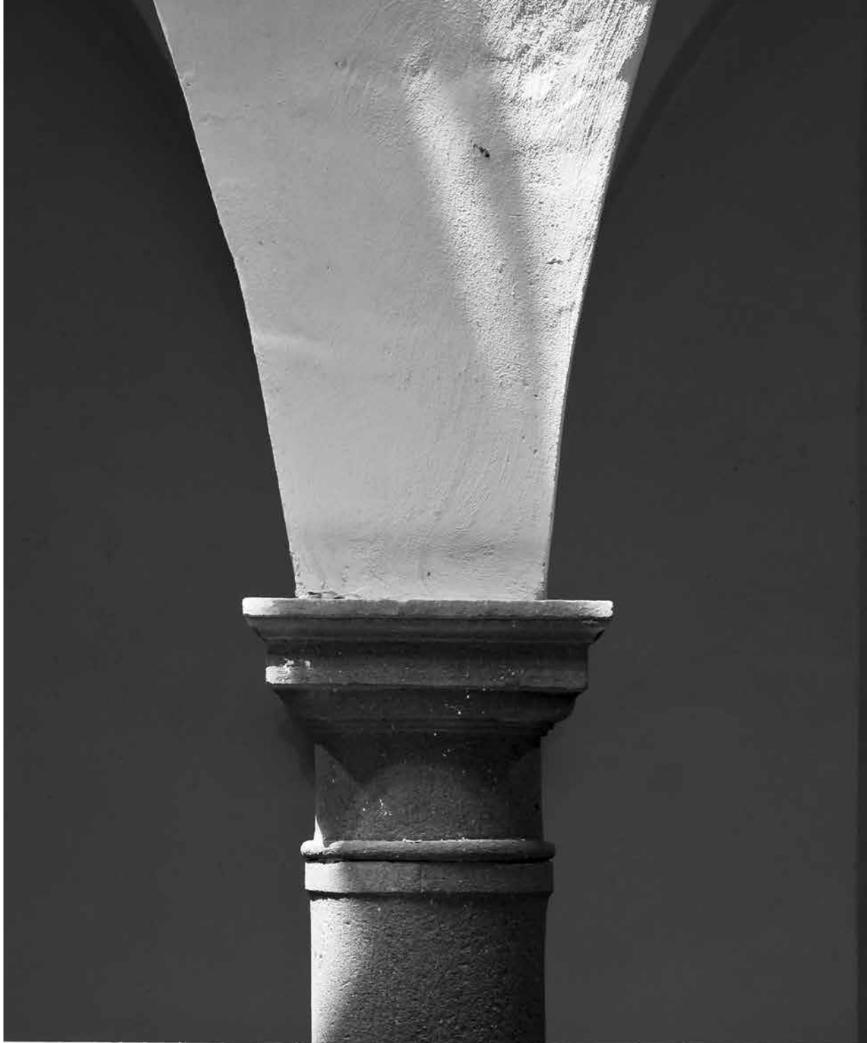
Dettaglio della colonna esistente e della nuova trave in cemento armato
