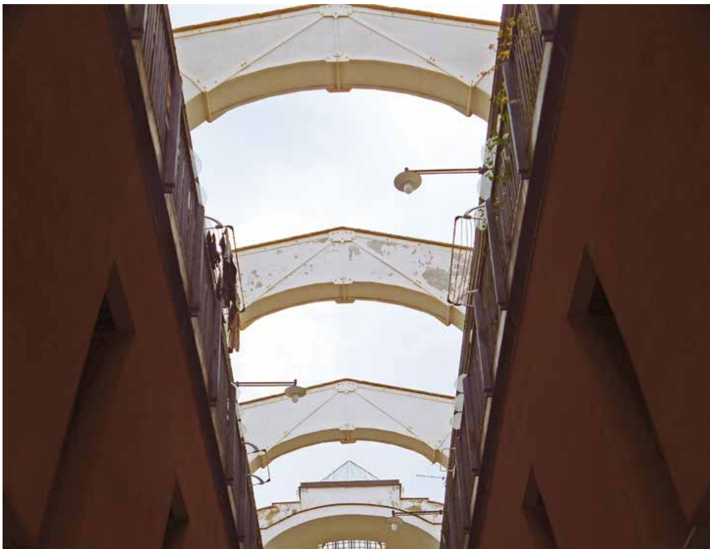
Veduta degli arconi della galleria dopo l'intervento di restauro
