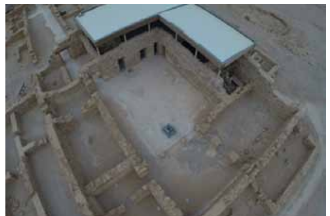
3 scatti fotografici dei 327 appartenenti al rilievo fotogrammetrico del Palazzo Occidentale, attraverso utilizzo di GoPro HERO+3 installata su drone.
