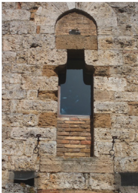
Figura 2. Apertura al primo livello sul prospetto Ovest.
