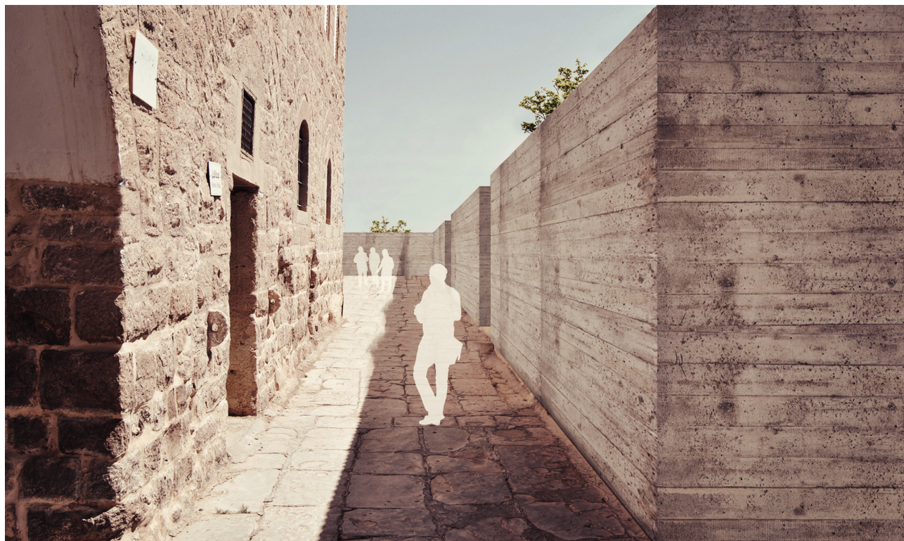
Fig. 7: Nabi Musa, vista nuovi servizi.
