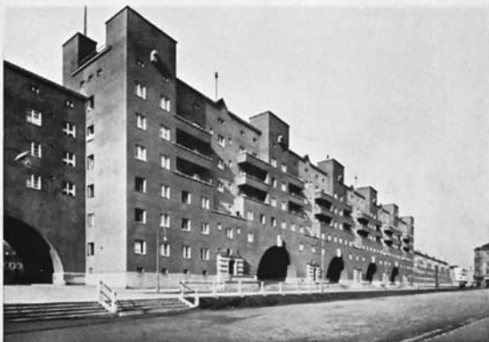
Ansicht der Fassadenfront Boschstrasse
