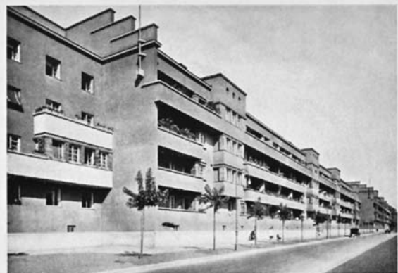
Teilansicht der Fassadenfront Boschstrasse
