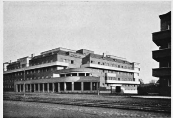
Ansicht der Front Geistingergasse, Ecke Heiligenstädter Straße
