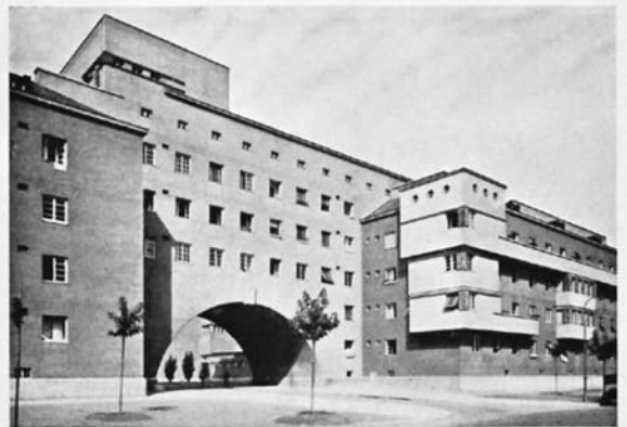
Fassadenpartie an der Ueberbrückung Halterastraße
