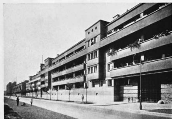
Teilansicht der Fassadenfront Boschstrasse
