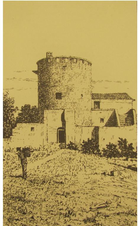
Fig. 2- Lecce, la torre di Bello Luogo [da De Giorgi, 1882].
