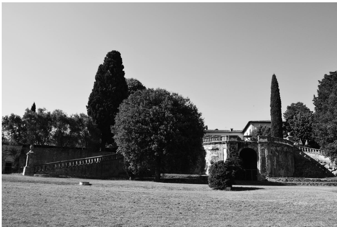
67. Firenze, villa di Lappeggi, giardino settecentesco e ninfeo allo stato attuale.
