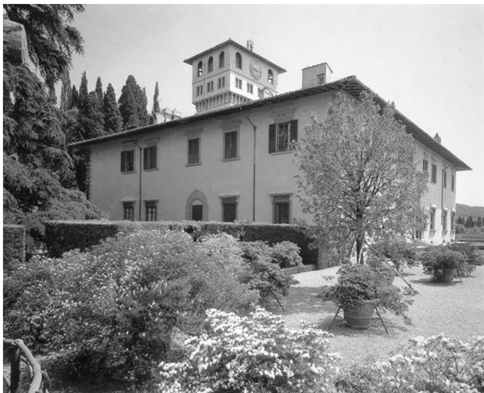
15. Firenze, villa Petraia, prospetto a ovest.
