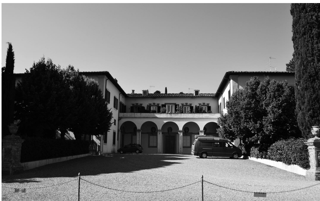
65. Firenze, villa di Lappeggi, portico di ingresso allo stato attuale.
