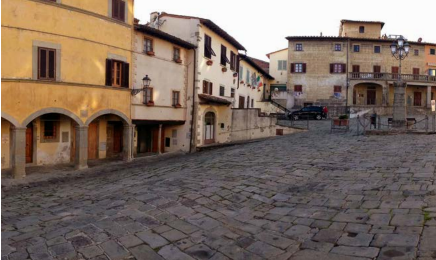
Pavimentazione della piazza a copertura delle cisterne ipogee
