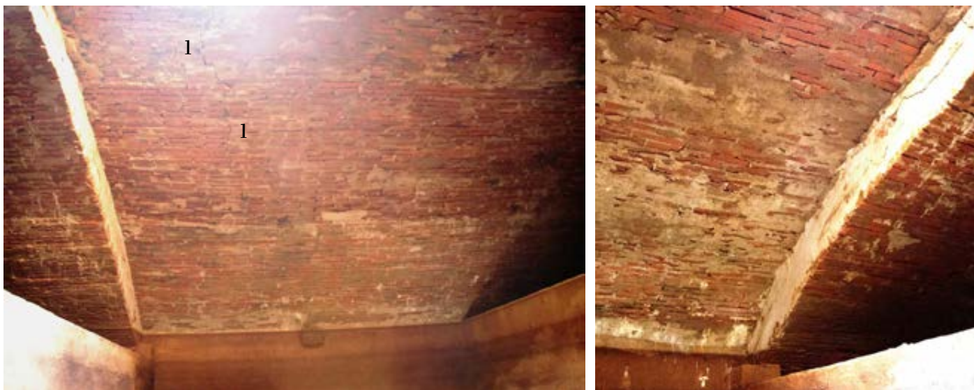
Figg. 1-2 Intradosso delle volte di copertura delle cisterne
