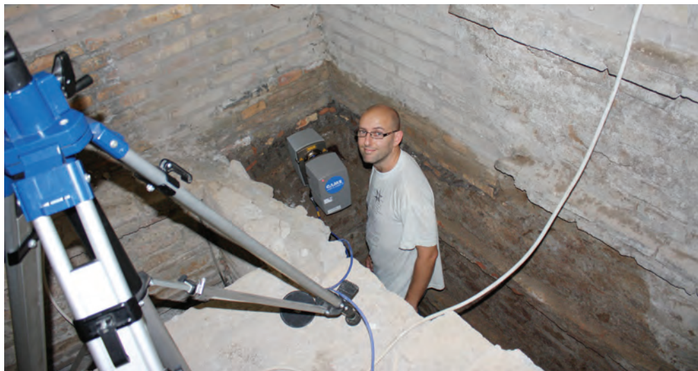
Fig. 4: Lo scanner laser 3D Cam /2 Faro Photon durante le fasi di rilievo.
