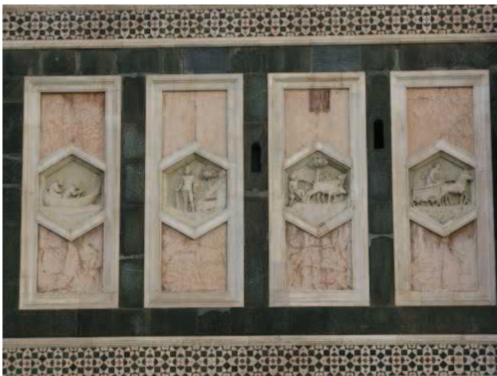
(fig. 32) Particolare delle due finestre che seguono lo sviluppo della scala in direzione sud-nord.
