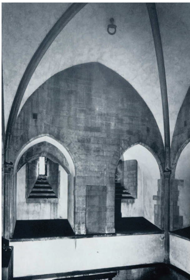
(fig. 31) Sala del piano terra, sulla sinistra l'arco falcato di sostegno alla scala.
