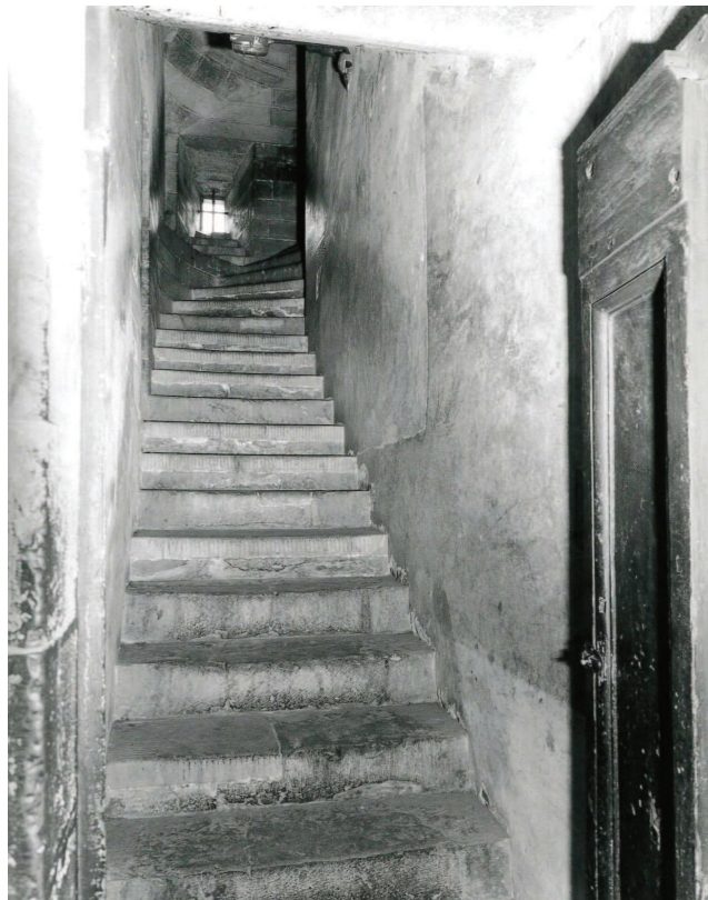
(fig. 56) Scala principale, prima della attuale sistemazione.
