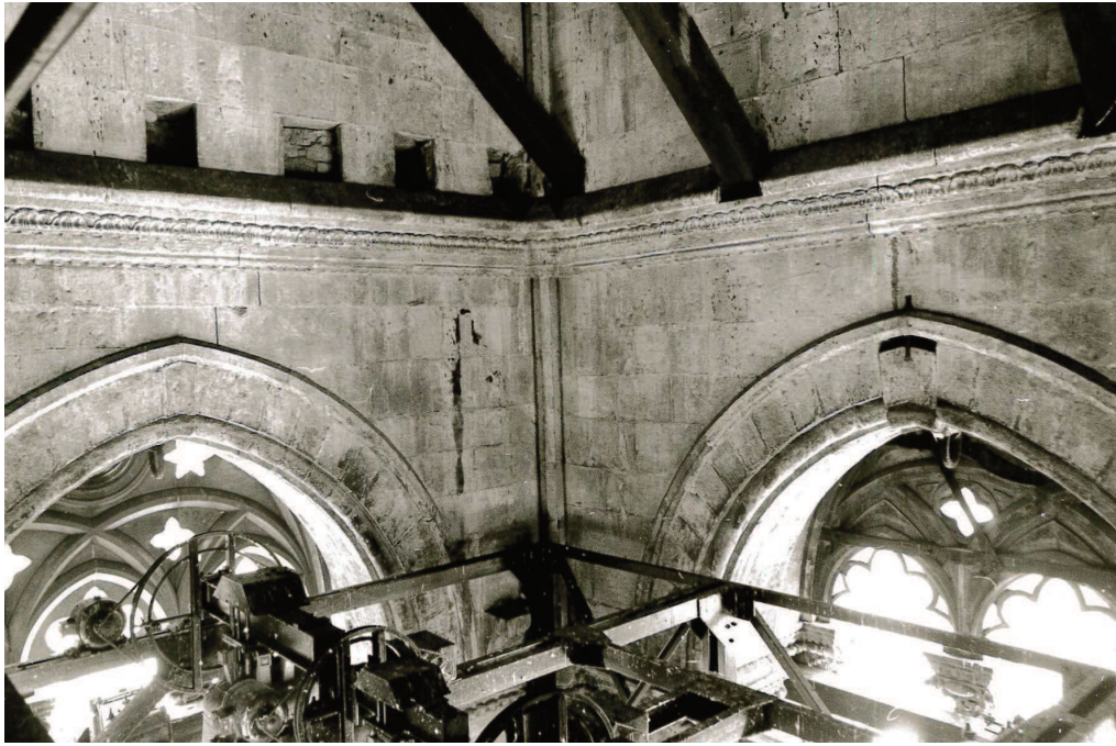
(fig. 51) Sala delle trifore, imposta del castello delle campane.
