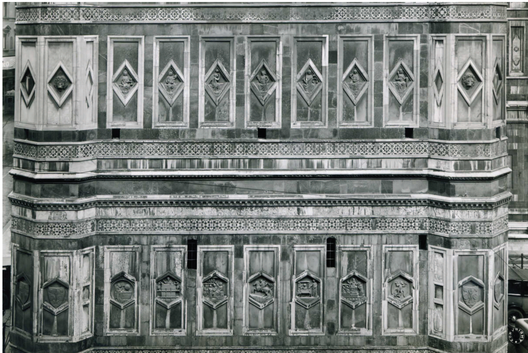
(fig. 23) Rilievi sul fronte sud del campanile.
