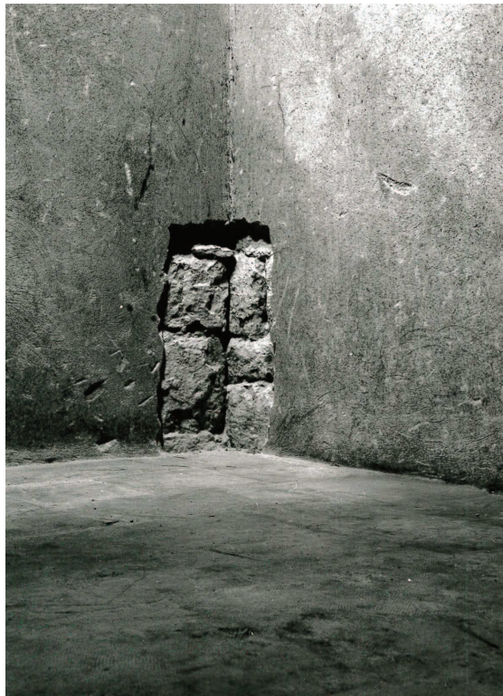
(fig. 36) Saggi eseguiti da Trachtenberg nell'aprile del 1969, sala del piano terra, lato meridionale.
