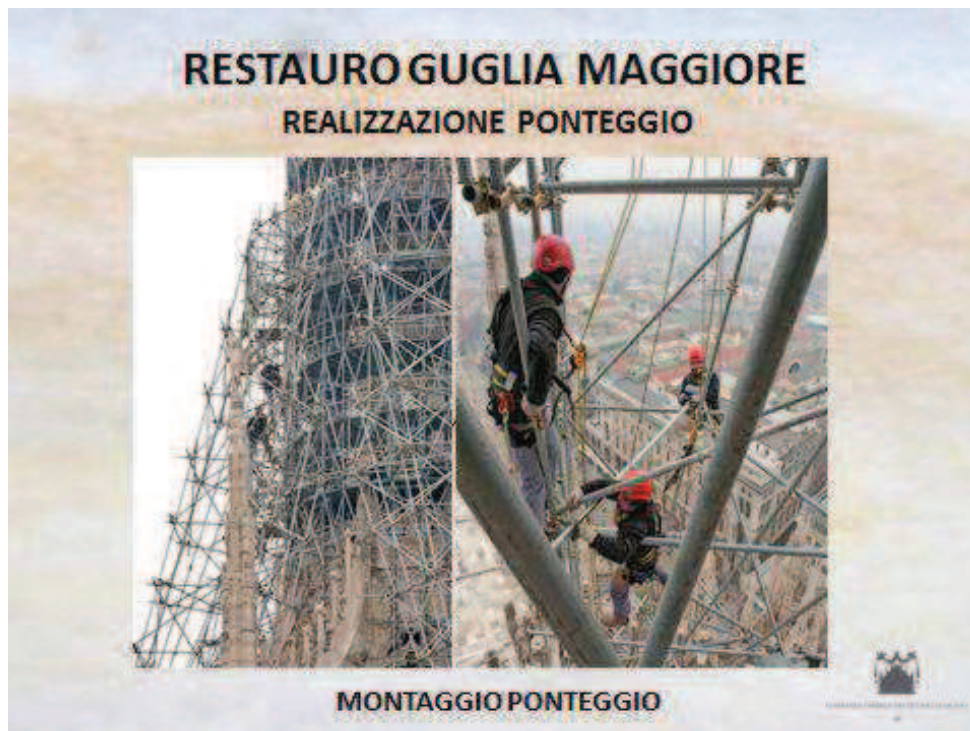
(fig. 86) Il ponteggio della guglia maggiore montato in occasione dei recenti restauri del 2009.
