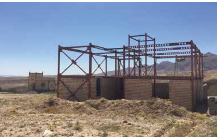
Figura 2. Esempio di un edificio in costruzione realizzato con criteri antisismici (controvento a croce di S. Andrea). Regione del Khorasan, Iran settentrionale.
