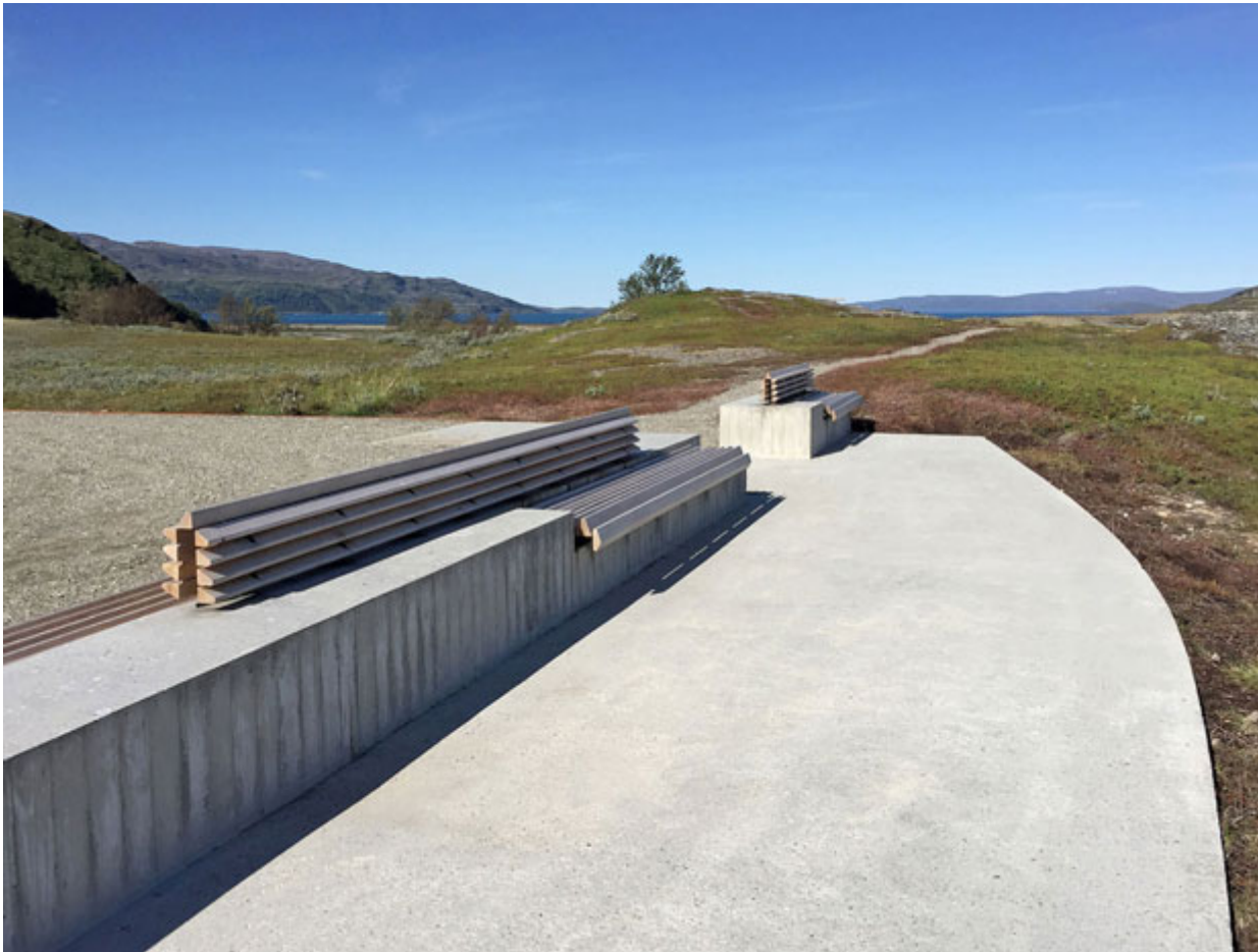
↑ L'area di sosta-parcheggio di ghiaia è delimitata da una piattaforma di cemento armato lunga e stretta sopra quale sono state ricavate delle panchine di legno. (Foto Pushak)
