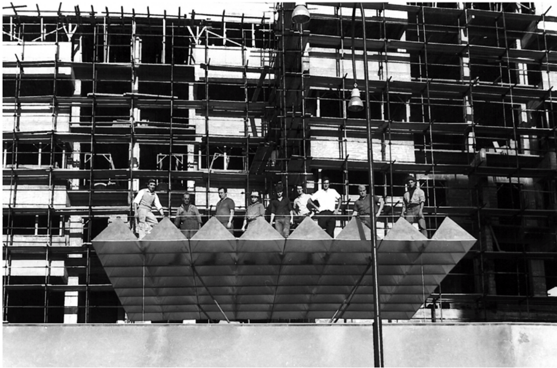
Fig. 83 - Gli operai dell'Impresa Piano Ermanno 'collaudano' la struttura di copertura, Erzelli (GE), 1965. (SSRCA)
