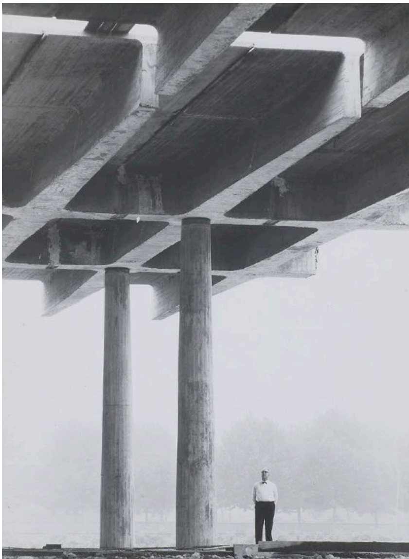
Fig. 59 - A. Mangiarotti, Deposito industriale Splügen Brau in costruzione, Mestre (VE), 1962. (Archivio A. Mangiarotti)
