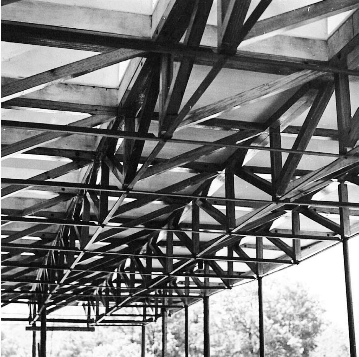
Fig. 96 - Vista della struttura di copertura durante il cantiere. (FRP)
