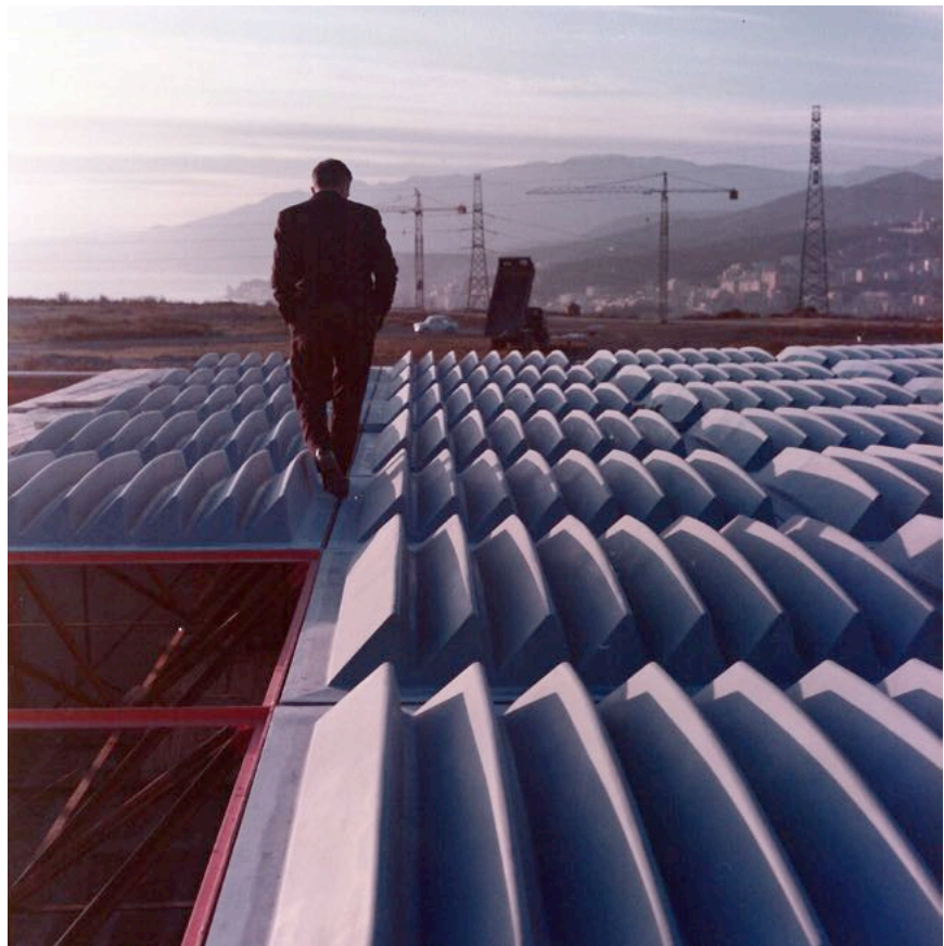
Fig. 75 - Operai dell'impresa al lavoro su uno dei pannelli di copertura a shed per lo studio Piano, Erzelli (GE), 1969. (FRP)
