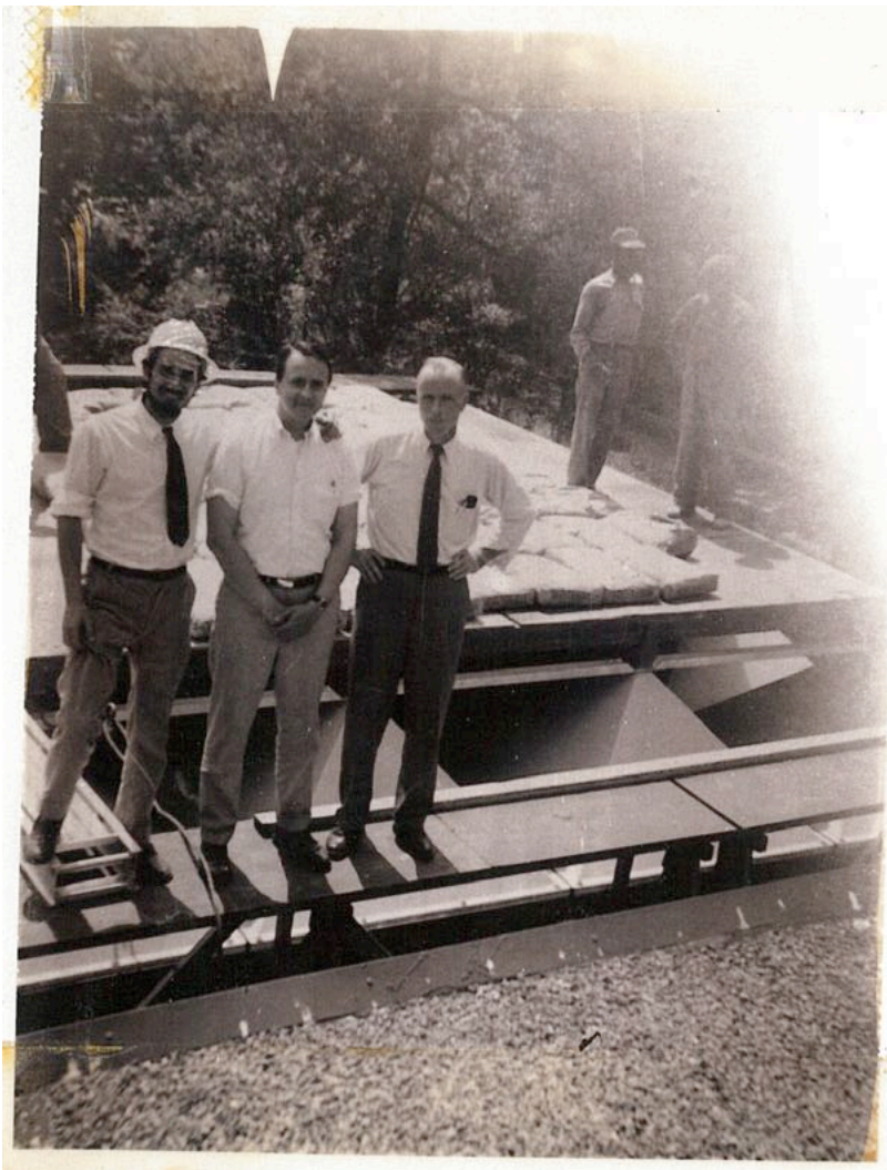
Figg. 165, 166 - Prove di carico del prototipo del lucernario nella sede della Barclay White & Company, Philadelphia, 29 maggio 1969. (FRP)
