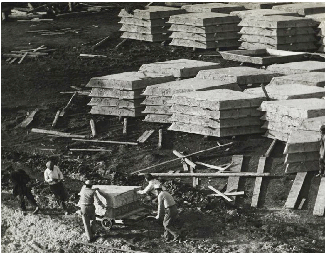
Fig. 14 - I tavelloni romboidali per la costruzione della cupola del Palazzetto, Roma, 1956. (MAXXI)
