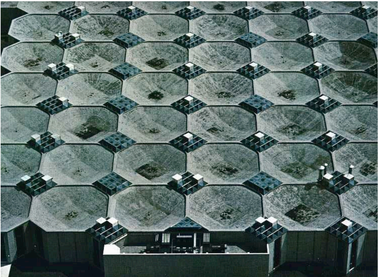
Figg. 159,160 - L. Kahn, A. Komendant, Fabbrica Olivetti-Underwood, Harrisburg (PA), 1967-70. (FRP)
