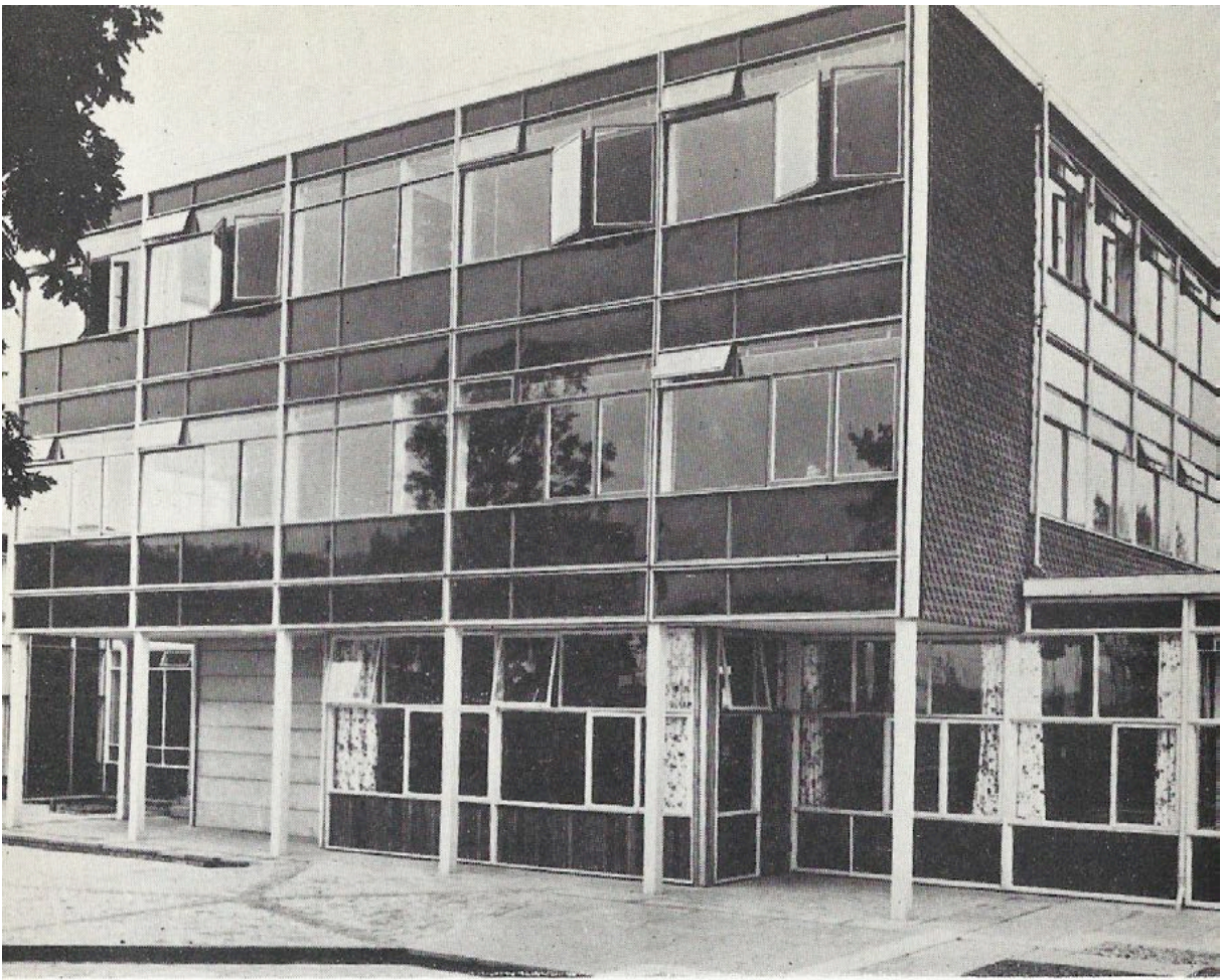
Figg. 32, 33 - Scuola costruita con il sistema di prefabbricazione CLASP, Hertfordshire, 1959.
