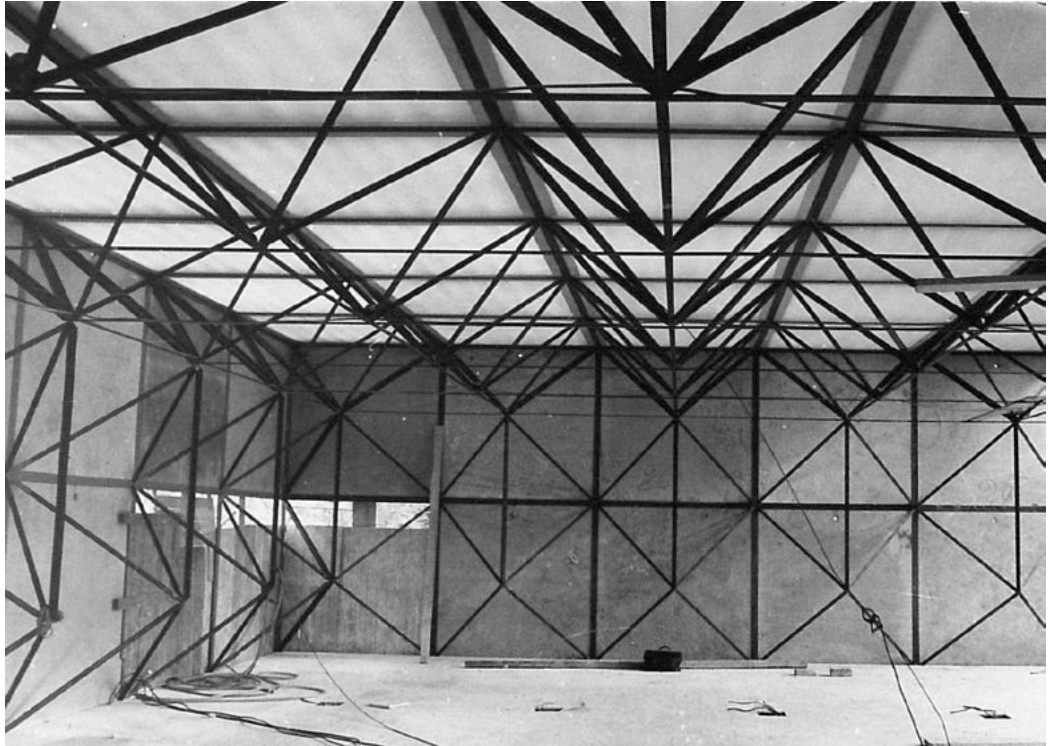
Fig. 52 - Il cantiere durante il montaggio dei pannelli di rivestimento, 1969. (FRP)
