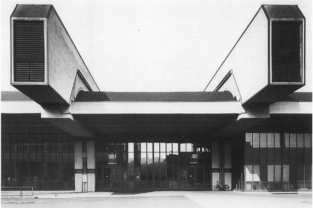
Fig. 111 - M. Zanuso, La trave cava in calcestruzzo armato dello stabilimento Necchi a Pavia, 1961.
