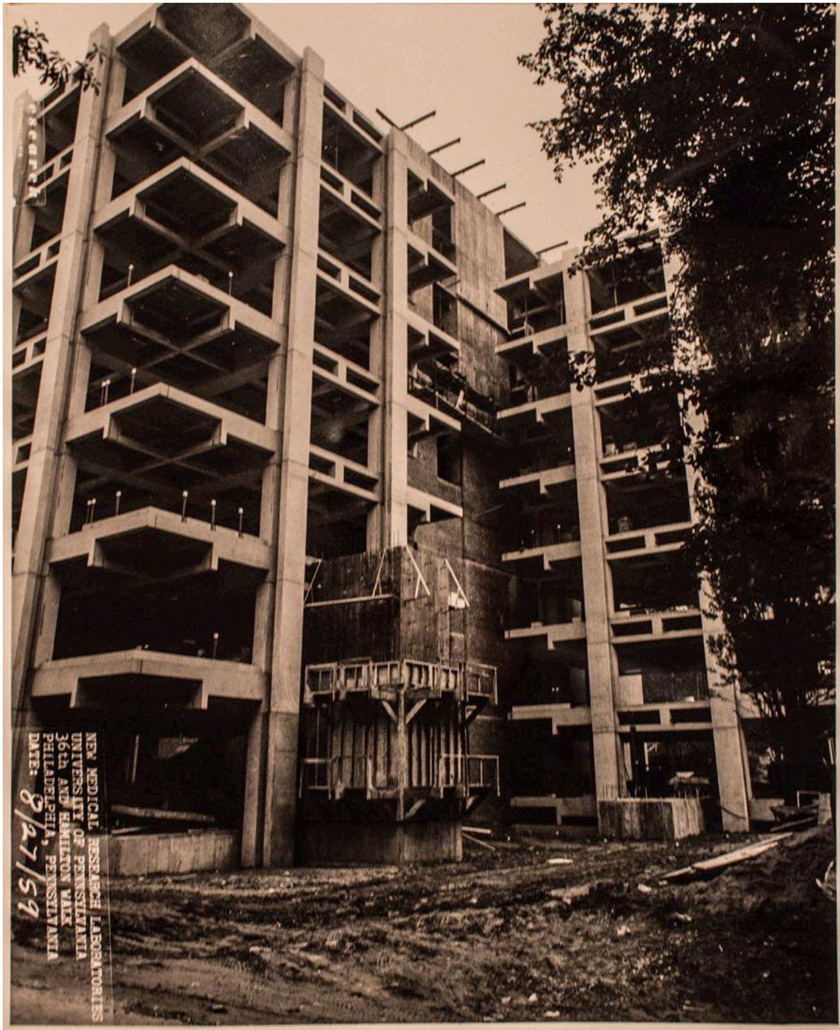
Fig. 158 - Lo scheletro strutturale dei Richards Medical Research Laboratories , Philadelphia, 1958. (AAUP)
