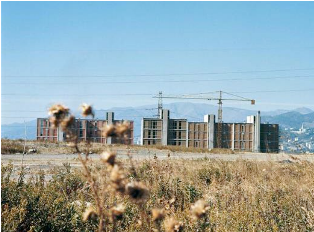
gli edifici del quartiere Boschetto in costruzione.
