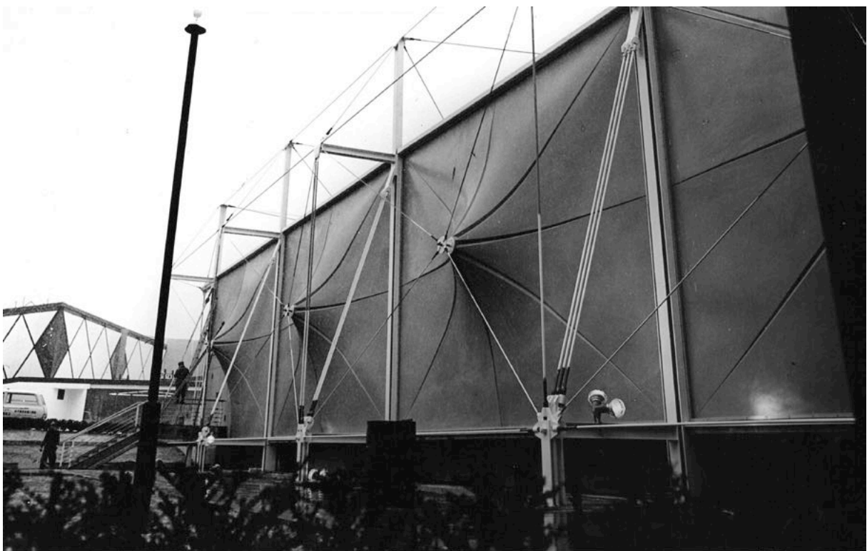
Figg. 184, 185 - Ultime fasi di montaggio del padiglione, Osaka, 1970. (FRP)
