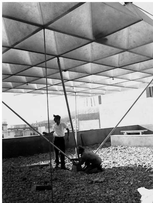
8. Renzo Piano segue il montaggio di una delle sue coperture in elementi piramidali di poliestere rinforzato, Genova Erzelli, 1965. © Fondazione Renzo Piano.
