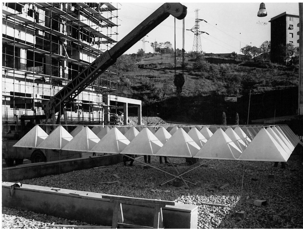
7. Una volta assemblati i pezzi la copertura viene sollevata da una gru. © Fondazione Renzo Piano.
