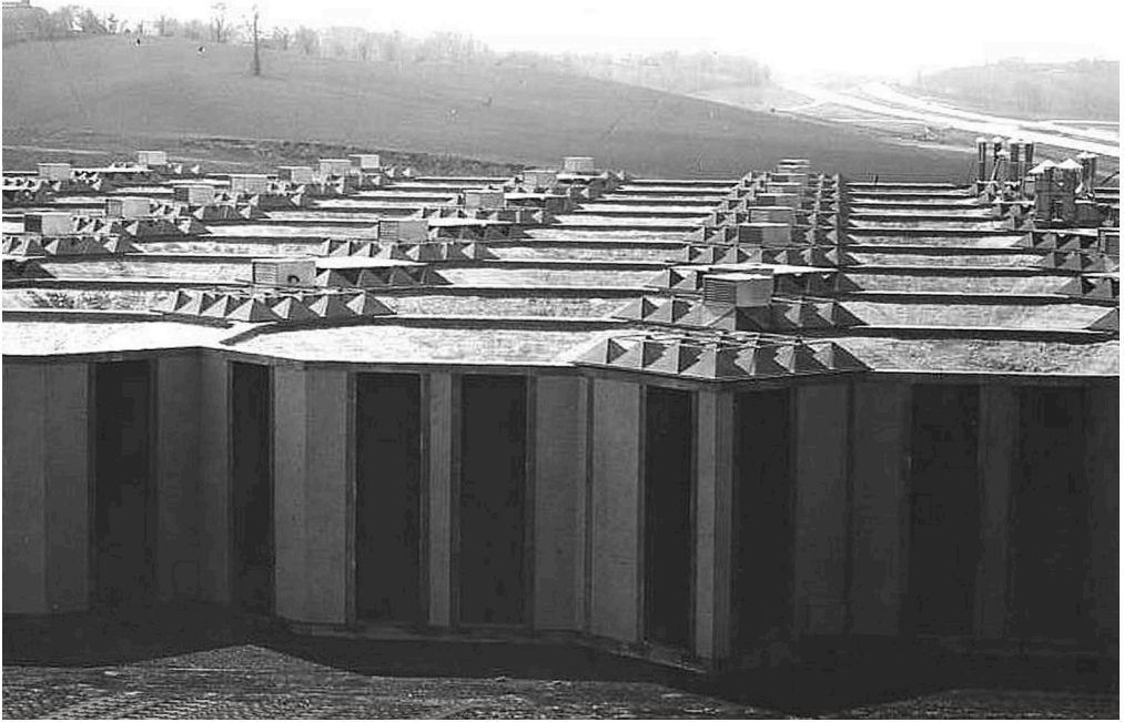
Figure 13. The completed Olivetti-Underwood factory, Harrisburg (PA), 1970. (Associazione Archivio Storico Olivetti)
