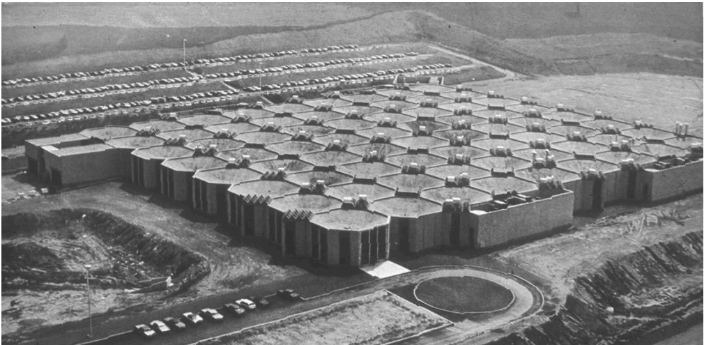
Figure 1. Olivetti-Underwood factory, Harrisburg (PA), 1970. Architect, L.I. Kahn; Engineer, A. Komendant. (Associazione Archivio Storico Olivetti)
