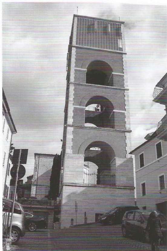
Fig. 7. Veduta della torre da via Gòmero (immagine dell'autore)
