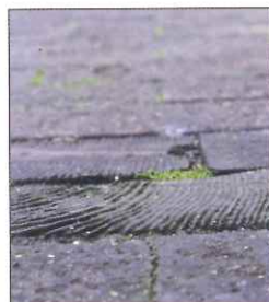
Residui di pavimentazione stradale nella periferia di Londra, a Checker Street. ( www.roadswerenotbuiltforcars.com/wood )
