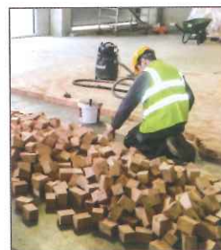
Moderna realizzazione di pavimentazione all'interno con i blocchi di legno ( www.endgrain.org.uk/portfolio/egger-uk-hex-ham ).
