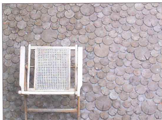
Pavimento per esterni fatto di piccoli ceppi di legno di conifera; l'inerte su cui poggiano e quello di riempimento sono ben drenanti.
