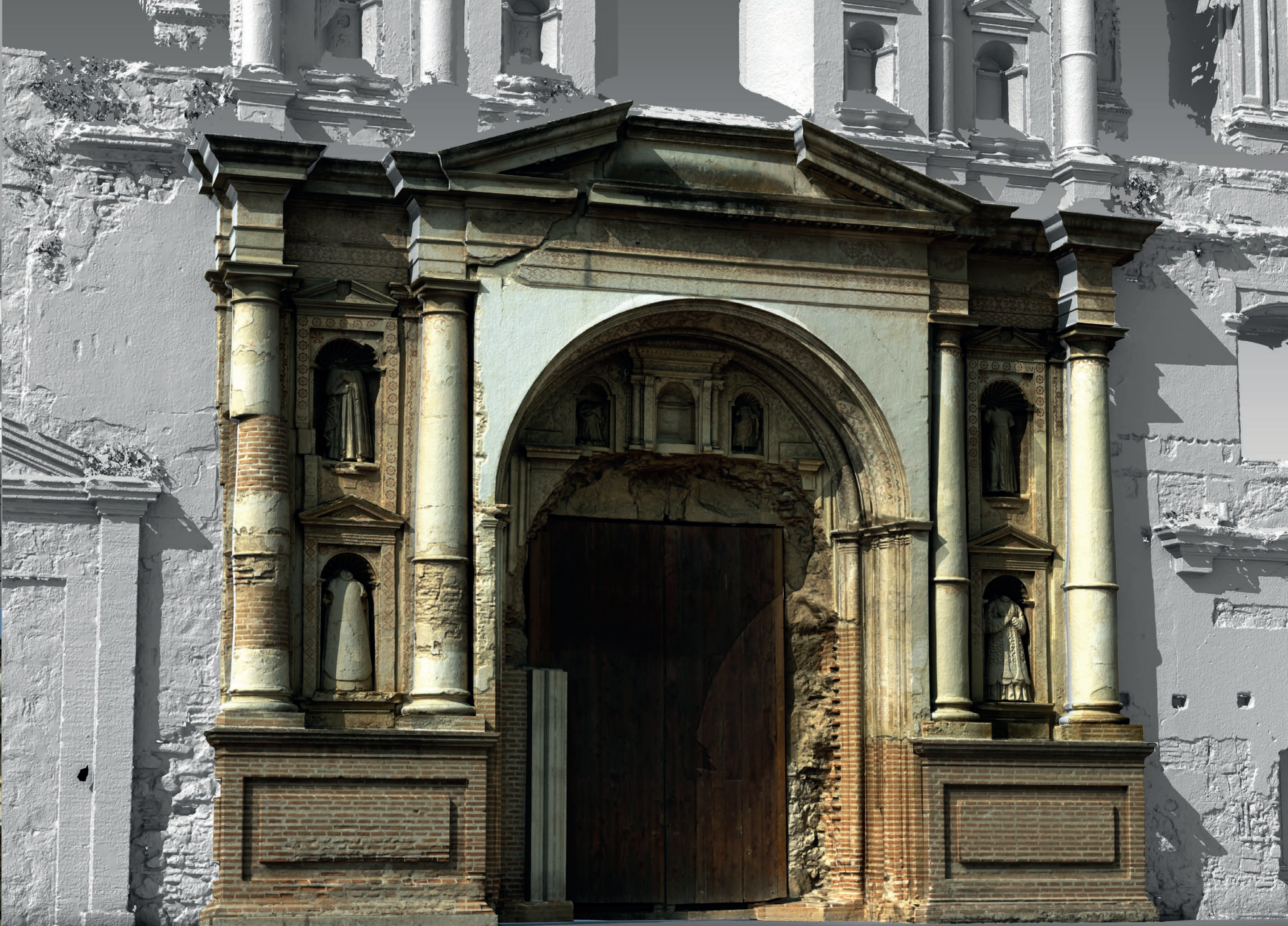
4. Operazione di frecciatura: associazione di punti omologhi tra oggetto rilevato e fotografia. I punti significativi individuati sul modello high-poly vengono associati ai loro omologhi visibili sui singoli fotogrammi per il recupero dei parametri esterni della camera (posizione e orientamento).
