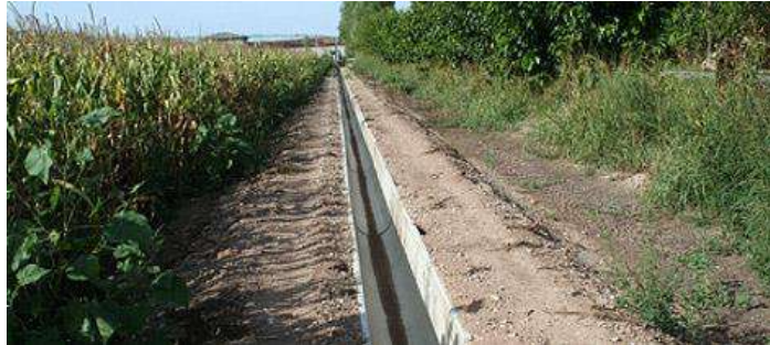
Fig. 34 - Esempio di canalizzazione ai fini irrigui
