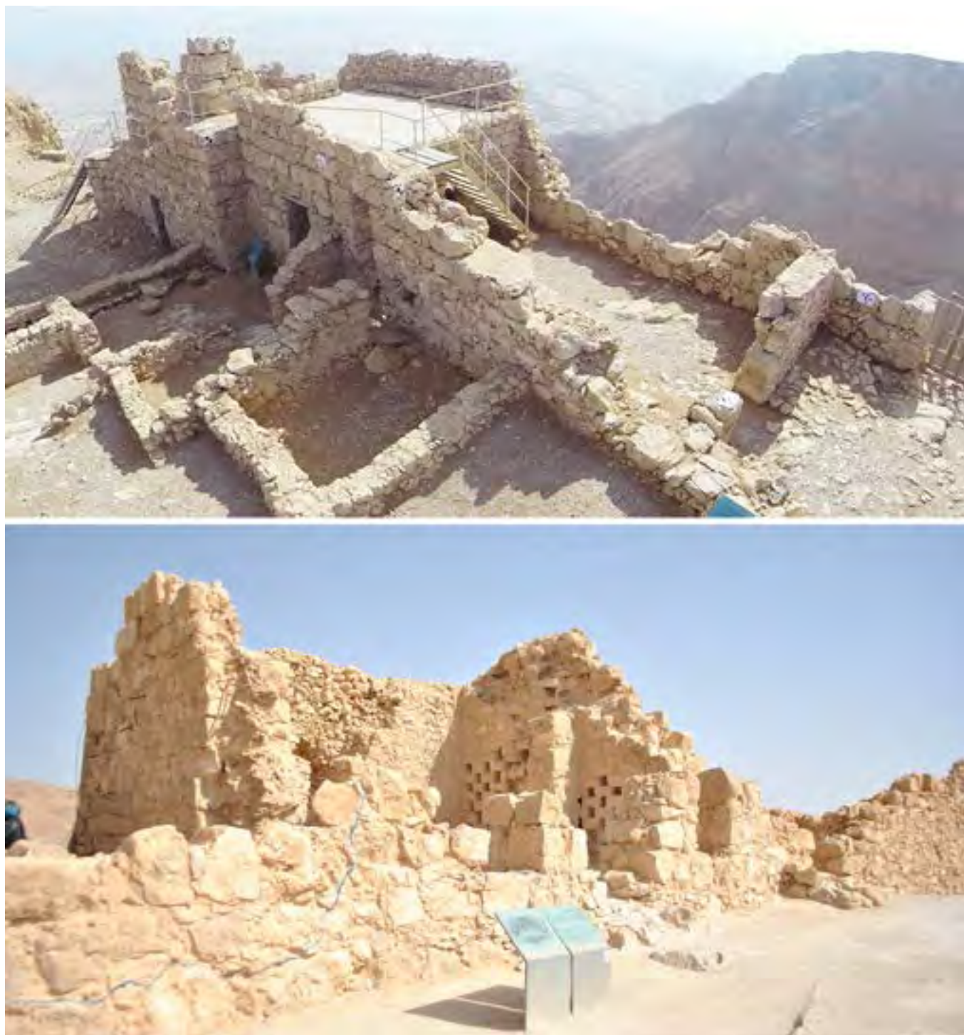
Fig. 22 Elementi tipologici della cinta muraria. (sopra) Gli ambienti n°1196-1201 che rappresentano un esempio di casamatta con torre di avvistamento. Lo si nota dal 'raddoppio' della muratura sul lato interno, in corrispondenza dell'odierna scala metallica. (sotto) Un esempio di torre colombaria (ambiente n°1028).
