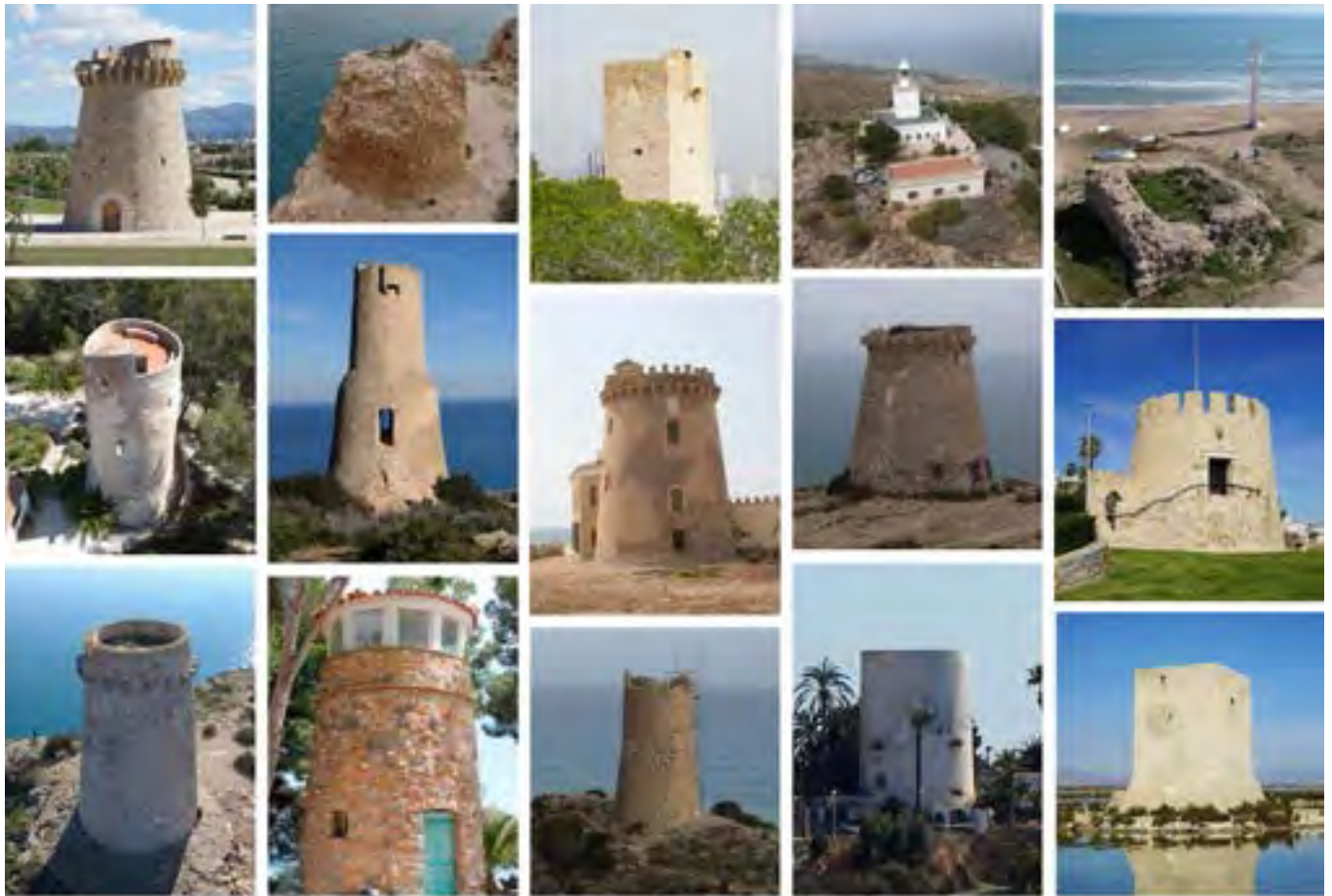
Fig. 61 Mosaico di fotografie di quindici torri costiere di diversa tipologia.
