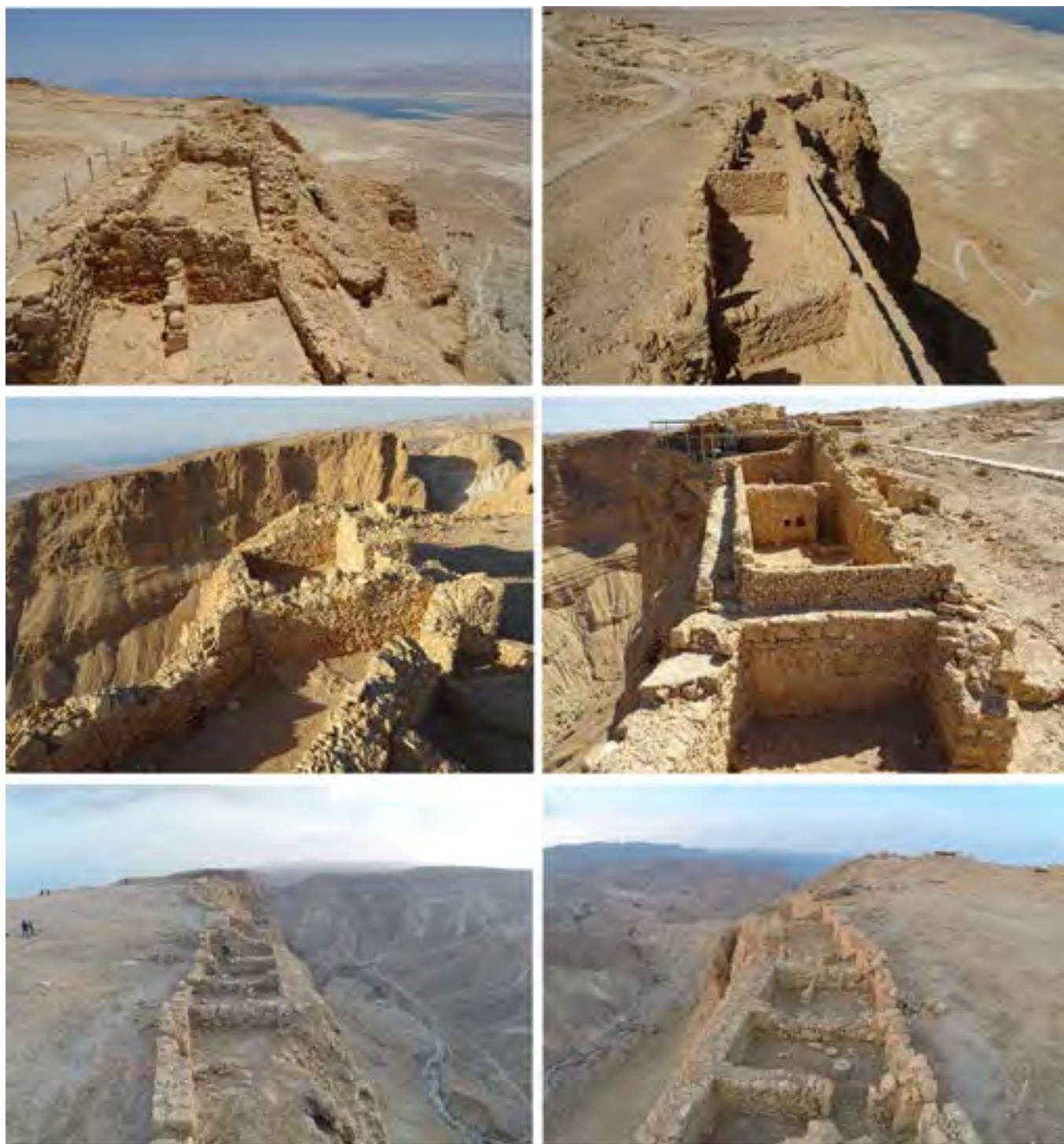
Fig. 21 Vedute di alcune porzioni di mura a casamatta. Si notino le diverse dimensioni degli ambienti in lunghezza ma la stessa dimensione di circa 4 m in larghezza, e lo spessore maggiore delle murature esterne.
