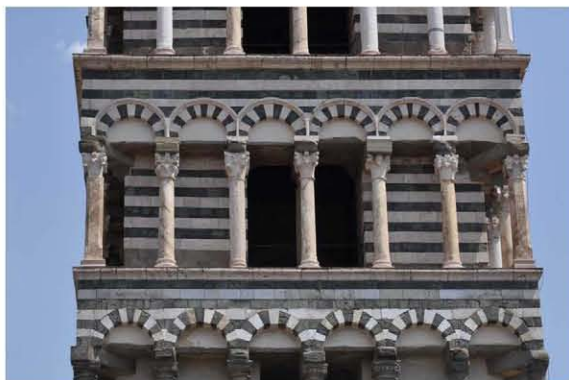
Localizzazione in facciata
