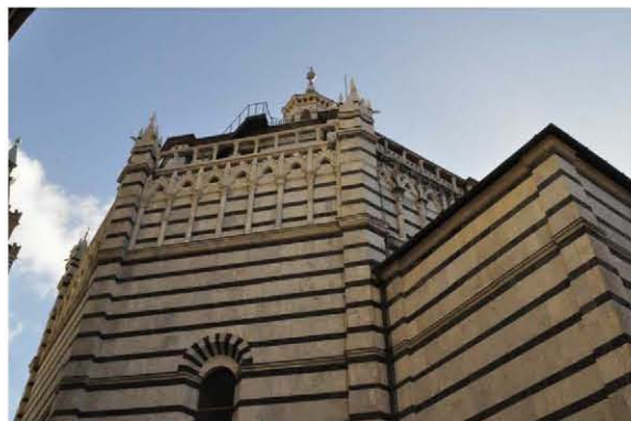
Localizzazione in facciata
