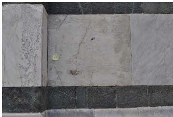
Localizzazione su paramento
