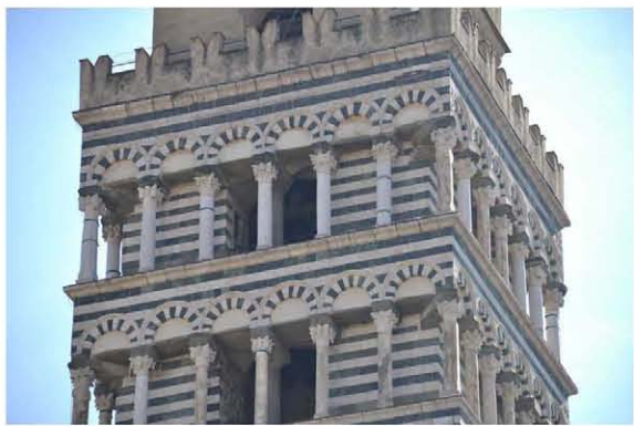
Localizzazione in facciata
