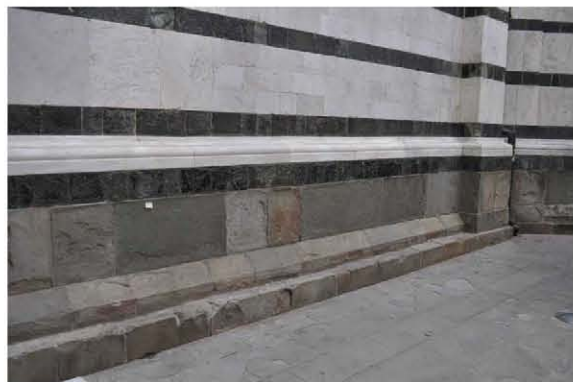
Localizzazione in facciata
