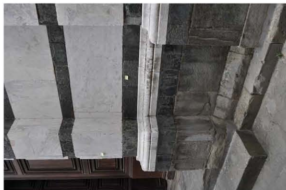
Localizzazione in facciata
