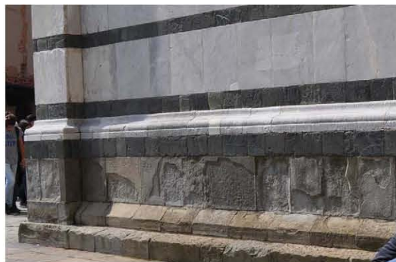
Localizzazione in facciata
