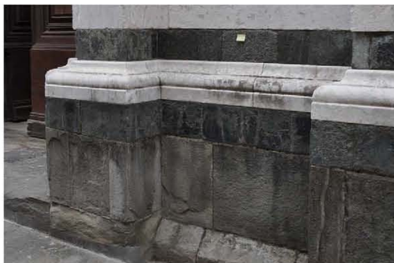
Localizzazione in facciata
