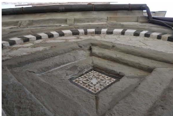
Localizzazione in facciata
