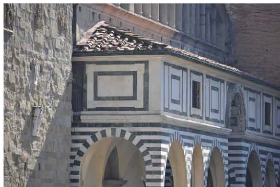
Localizzazione in facciata
