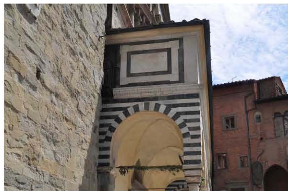
Localizzazione in facciata
