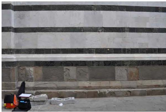
Localizzazione in facciata
