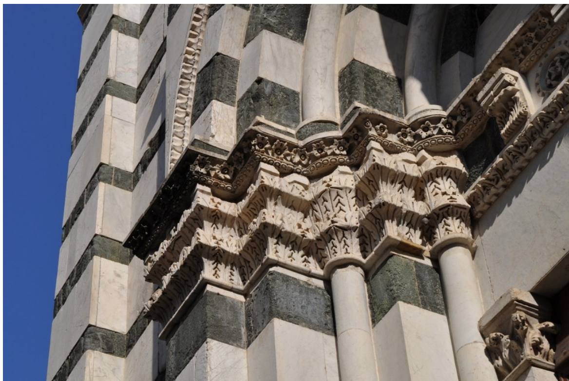
Fig.1. 13: Particolare del portale sud del Battistero di San Giovanni in Corte, Pistoia
