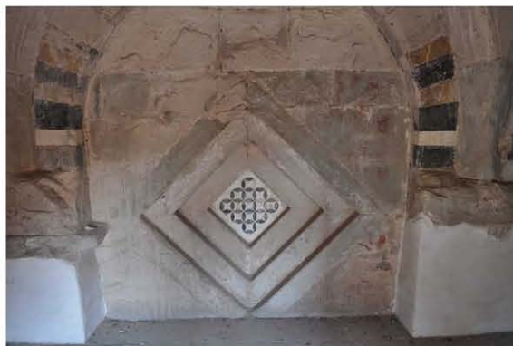
Arcata dell'antica facciata
