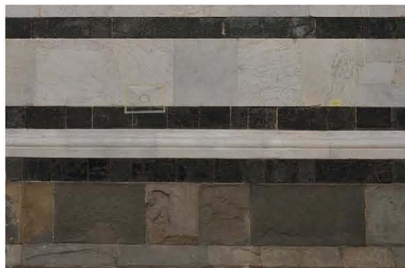
Localizzazione in facciata
