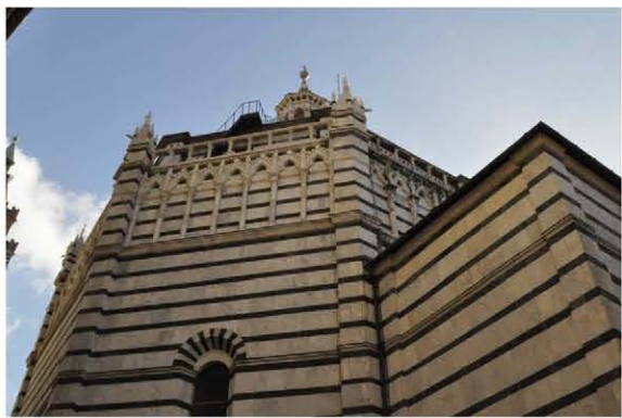
Localizzazione in facciata
