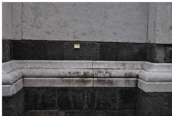
Localizzazione su paramento
