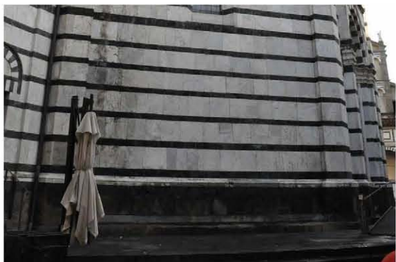
Localizzazione in facciata
