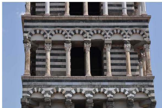
Localizzazione in facciata
