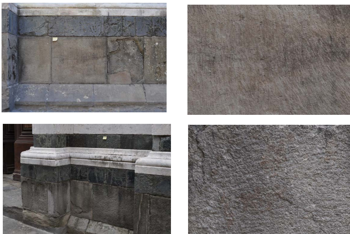
Fig.1. 34: Comparazione lastre in arenaria, inquadramento e ingrandimento, AA05 (sopra) e AA09 (sotto), anno trattamento 2000.
