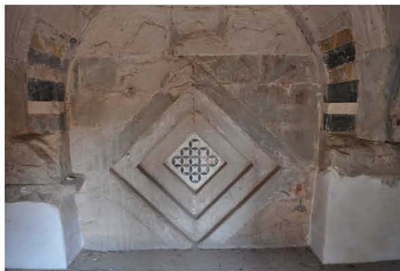
Arcata dell'antica facciata
