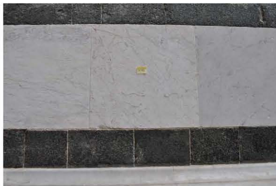
Localizzazione su paramento
