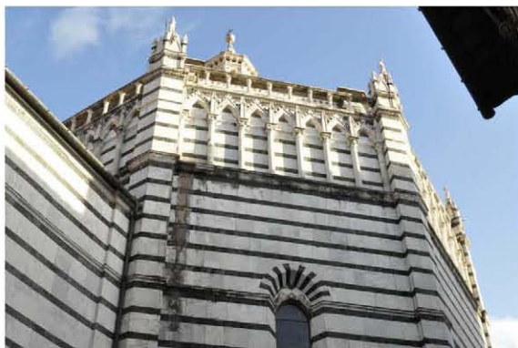
Localizzazione in facciata
