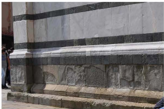
Localizzazione in facciata
