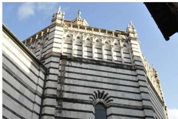
Localizzazione in facciata
