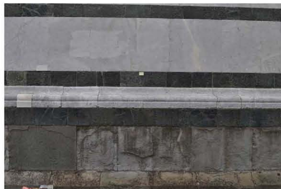
Localizzazione su paramento
