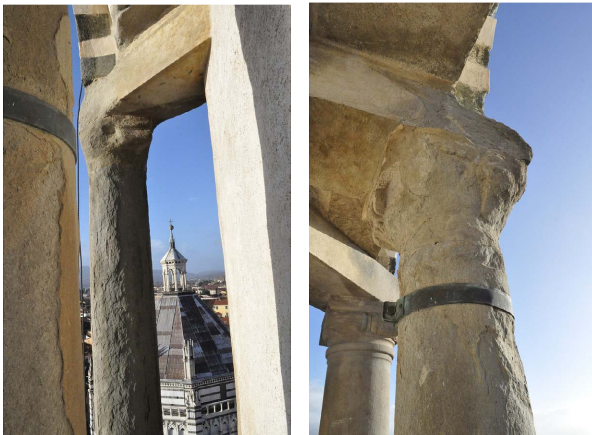
Fig.1. 32: Colonne in pietra serena del primo ordine loggiato del campanile
