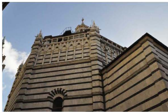
Localizzazione in facciata
