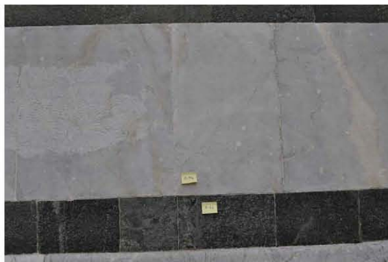
Localizzazione su paramento
