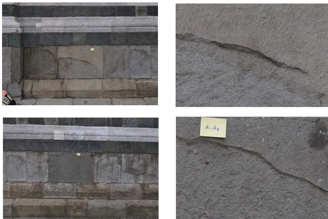
Fig.1. 35: Comparazione lastre in arenaria, inquadramento e ingrandimento, AA07 (sopra) e AA08 (sotto), anno trattamento 2014
