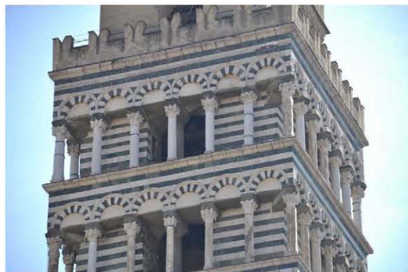
Localizzazione in facciata
