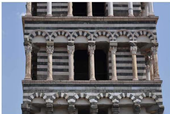
Localizzazione in facciata
