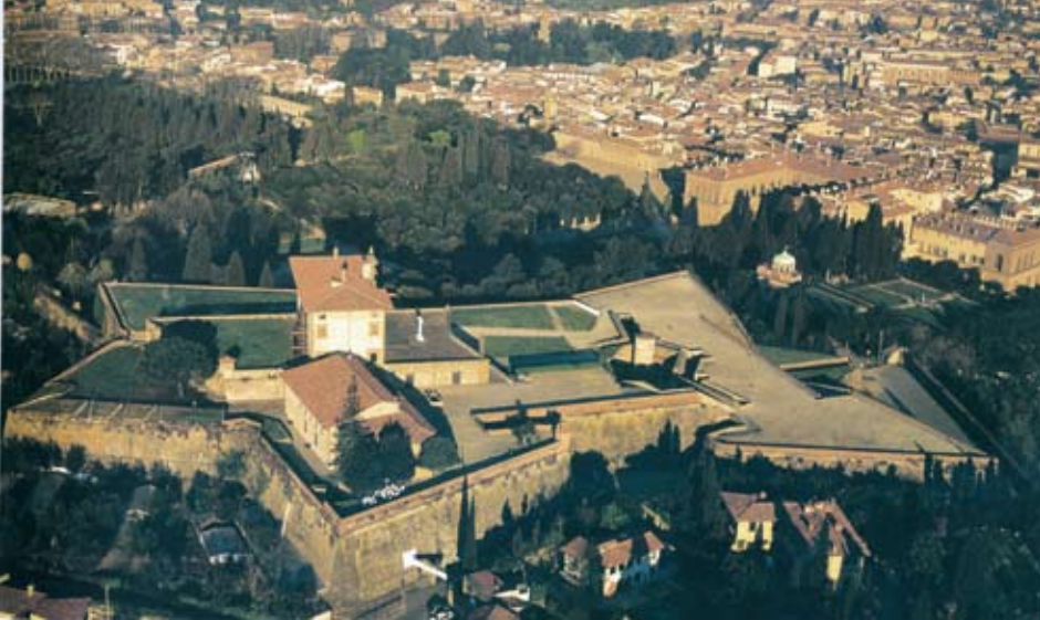
Fig. 3. Palazzina del Belvedere con la fortezza.
