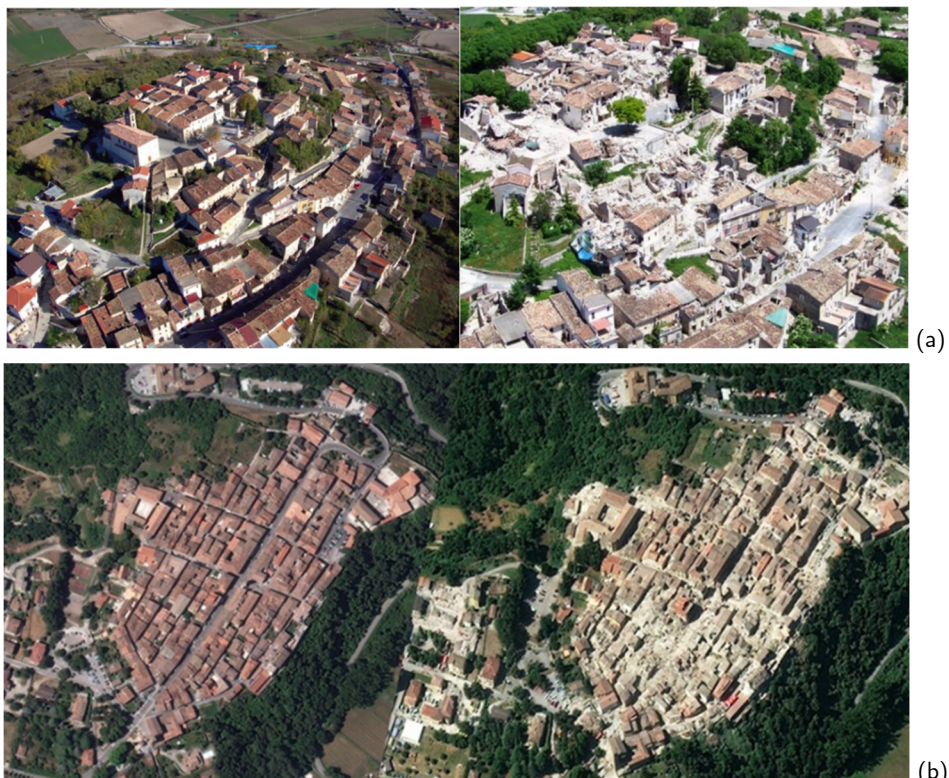
Figure 1-1: Castelnuovo (L'Aquila) - 06/04/2009 (a), Amatrice (Rieti) - 24/08/2016 (b).
