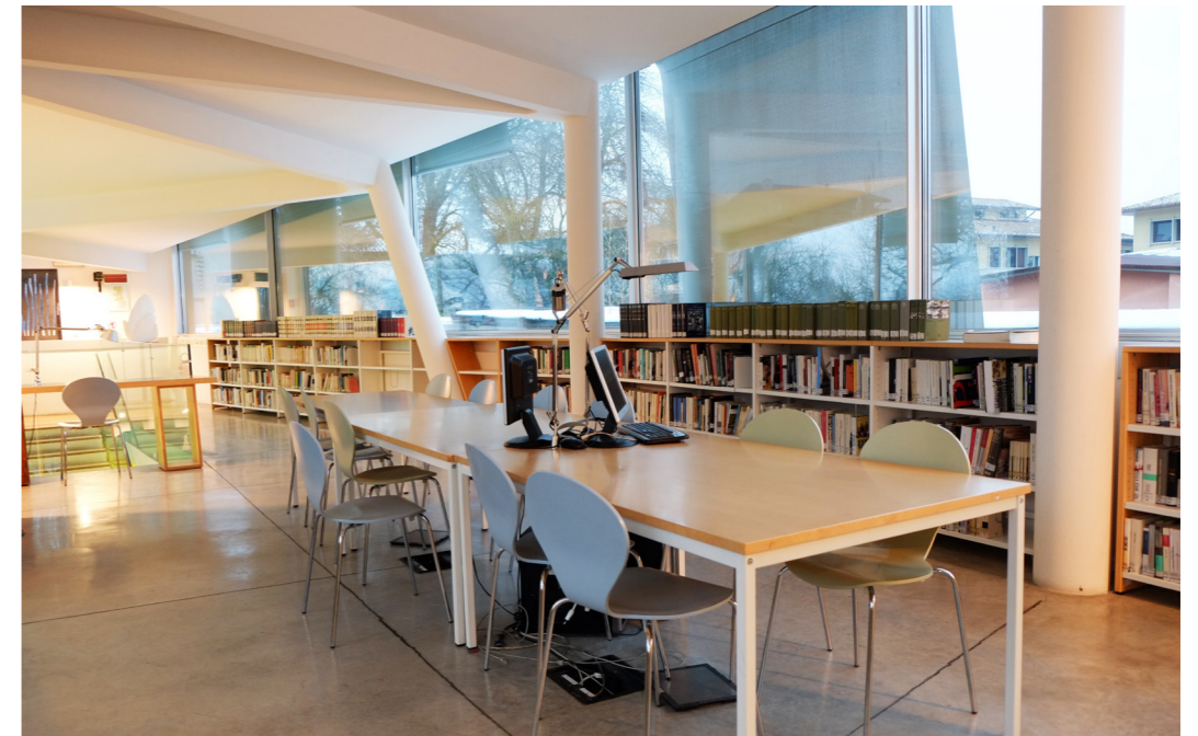
Figura 6.56 Interno della Biblioteca Pablo Neruda di Albinea, caratterizzato da ampie vetrate, dove le tende automatizzate regolano con l'ausilio di un computer in base alla quantità della luce solare.
