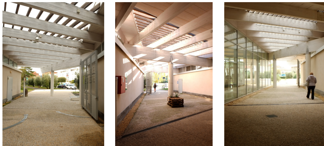
Figura 6.4 (sotto) Immagini relative ai tre accessi della struttura del centro Le Creste.
