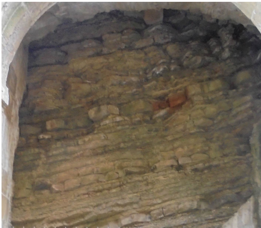
➔ Fig. 3.4 Affioramenti di Pietraforte nel Giardino di Boboli: tipica stratificazione di basso spessore
