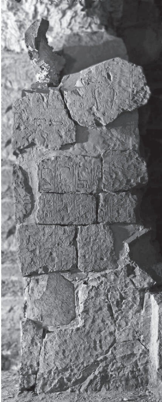
Tav. 4: parete ovest del passaggio
