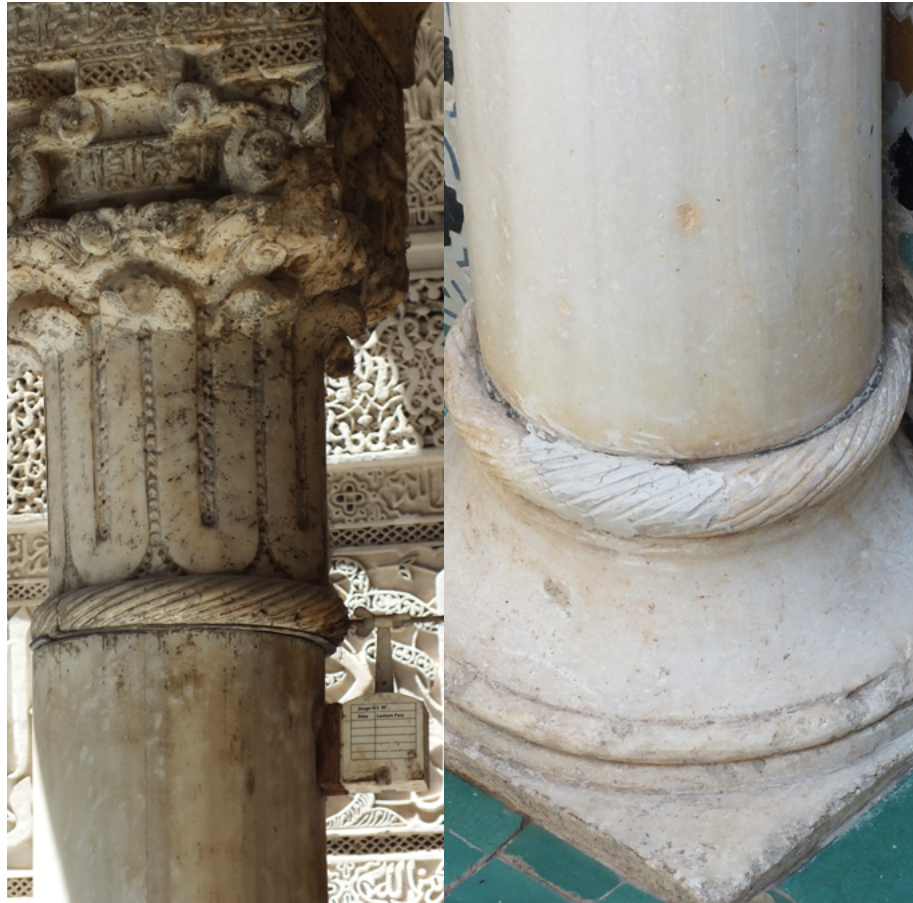
Figura 4.21 Isolatori sismici presenti in due colonne della Medersa Attarine
