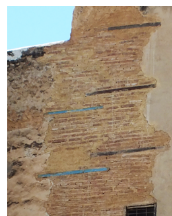
Figura 4.20 Elementi lignei all'interno della muratura
