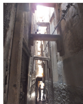
Figura 4.23 Uno dei casi più preoccupanti di spanciamiento verticale riscontrato nella medina di Fes. In un derb largo circa un metro, la muratura di un edificio arriva quasi a toccare in sommità l'edificio di fronte, a circa 10-12 metri dal suolo.
