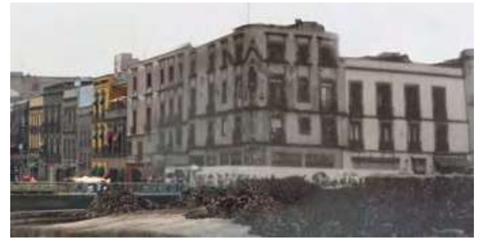
Fig. 50 - Reconstitución digital de la casa de las Ajaracas vista desde el interior de Templo Mayor, fotografía base de 1990. Se aprecia un deterioro en una etapa avanzada. A un costado La antigua casa de las campanas aún edificada. Técnica usada Photoshop.
