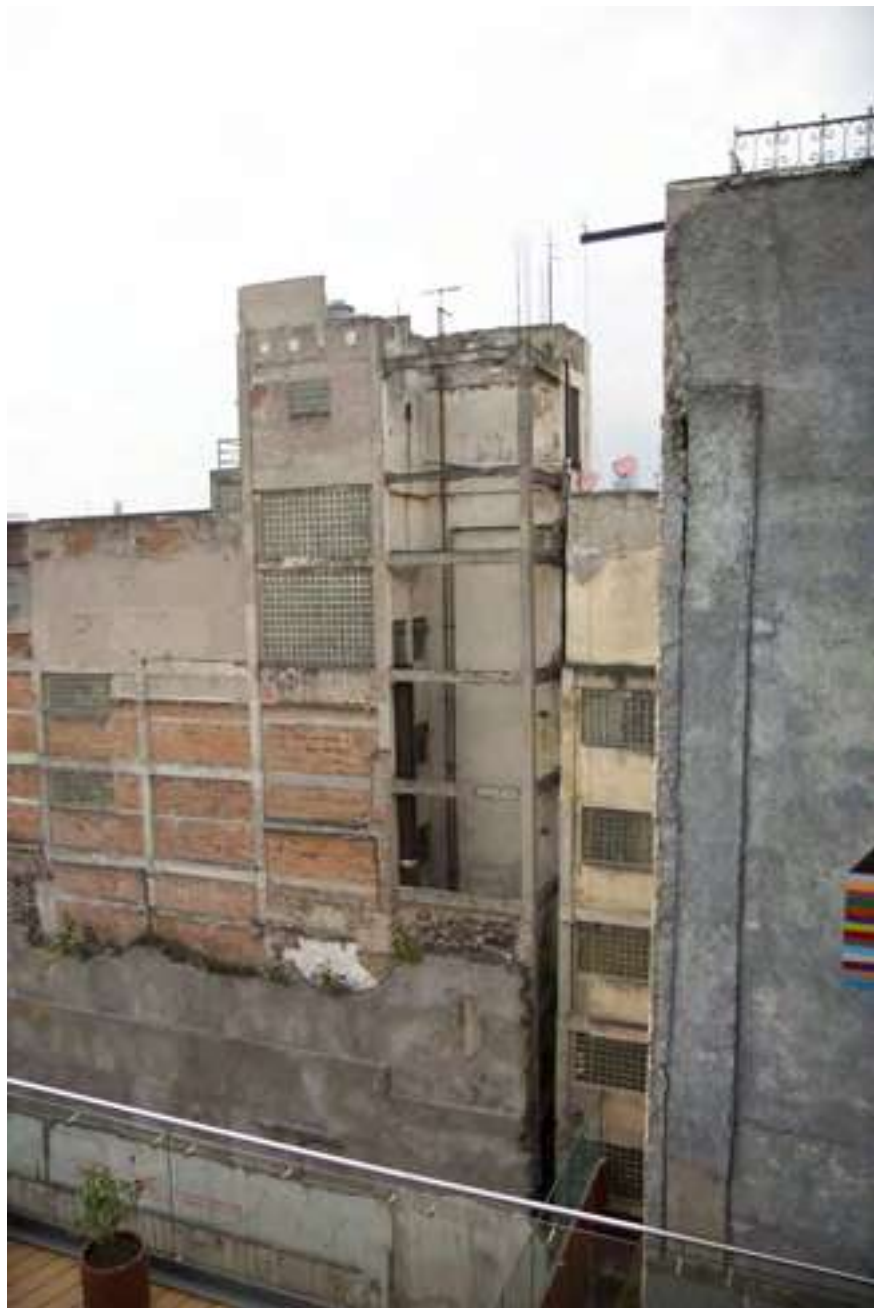
Fig.129 Vista di un fabbricato all'interno dell'isolato, che permette di comprendere la sovrapposizione e l'accostamento di strutture in cemento armato con edifici antichi
