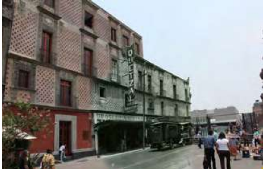
Fig. 48 - Reconstitución digital de la casa de las Ajaracas vista desde la Avenida República de Guatemala, fotografía base de 1930 donde se aprecia en planta baja el área de comercio y en fachada el uso de espectaculares. En contraste con una fotografía de 2019. Técnica usada Photoshop.
