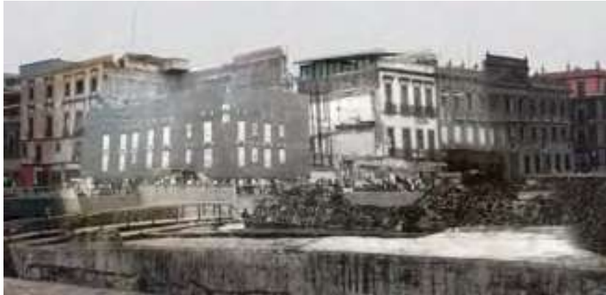
Fig.55 - Reconstitución digital de la acera oriente de la Av. República de Argentina, fotografía base de 1999. Se muestra a casa de las ajaracas en riesgo de colapso cubierta por una gran lona. De igual forma se observa a la Casa de las Campanas prácticamente demolida en su totalidad. Técnica usada Photoshop.
