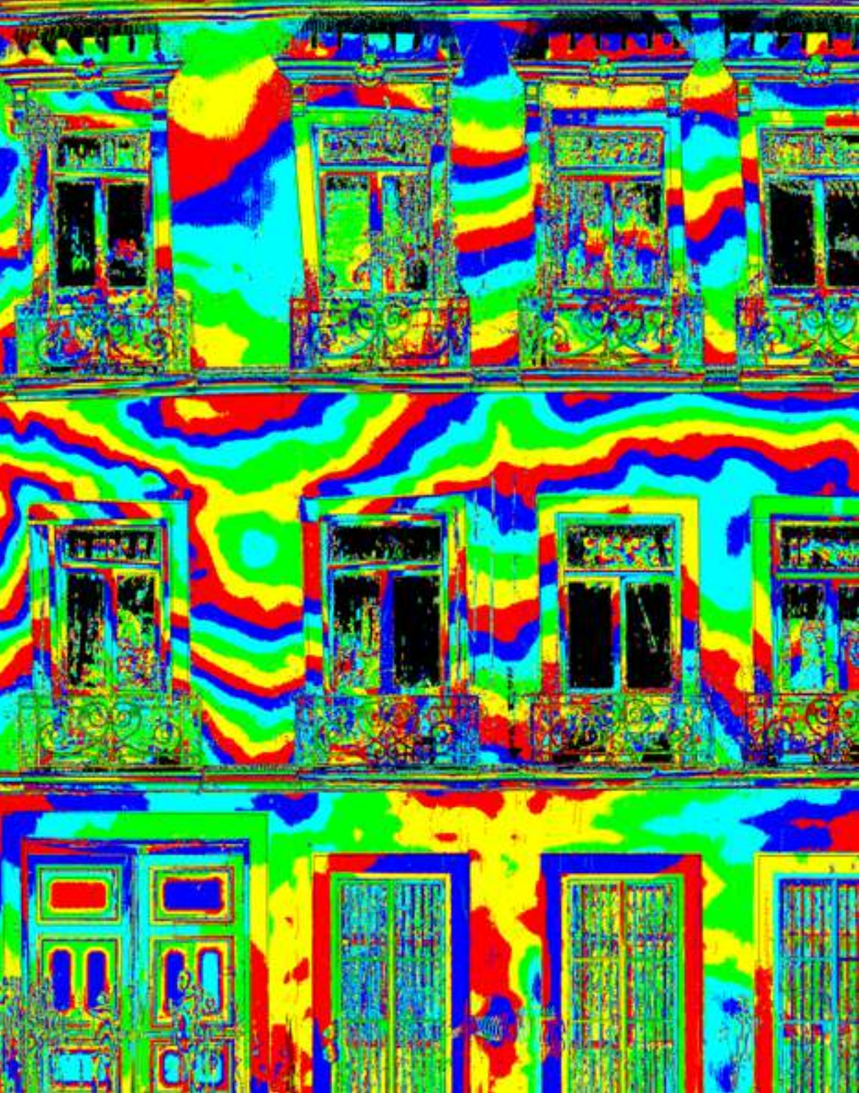
Fig.129 Deformazioni lungo una facciata dell'isolato caso studio
