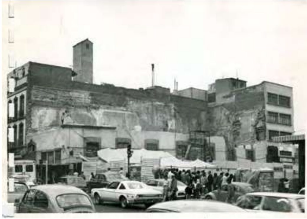
Fig.43 - Fotografía de 1978, se muestran los trabajos de demolición de los edificios de la acera poniente de la Avenida República de Argentina en 1978 cuyo proyecto tuvo como principal objetivo el salvamento arqueológico del Templo Mayor
