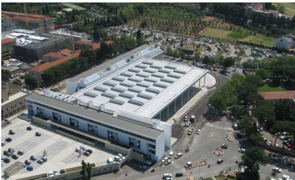
Figura 04.47. Una vista del nuovo centro servizi NIC [www.aou-careggi.toscana.it].
