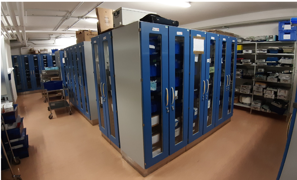
Figura 04.52. Un locale di deposito e stoccaggio farmaci e dispositivi medici.
