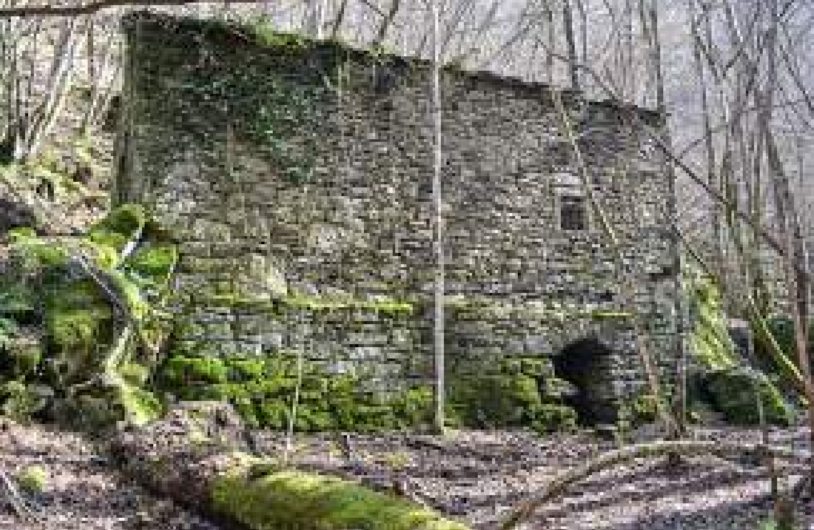
Fig. 107 Mulino in località Le Mandriole in Casentino (Comune di Pratovecchio Stia, AR). In basso l'arco per l'ambiente voltato del 'carcerai' in cui si localizzavano, fino agli anni '60 del XX secolo, le ruote idrauliche (2014)
