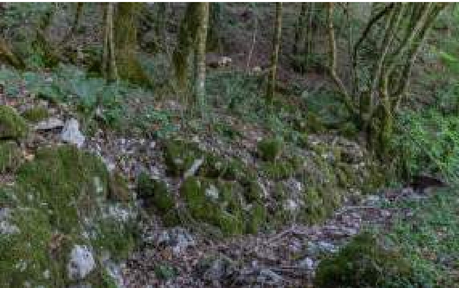
Fig. 36 Resti di strutture murarie presso Mezzalla (2019)
