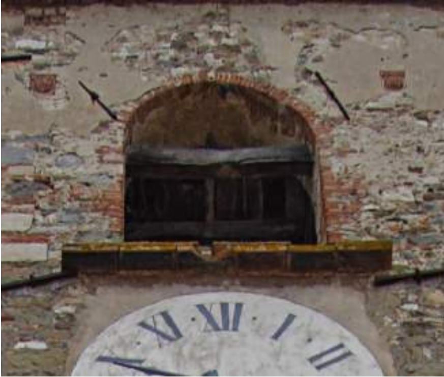
Figg. 119 Cerchiatura lignea della cella campanaria messa in opera dal Nozzolini durante i restauri eseguiti a inizio XVII secolo
