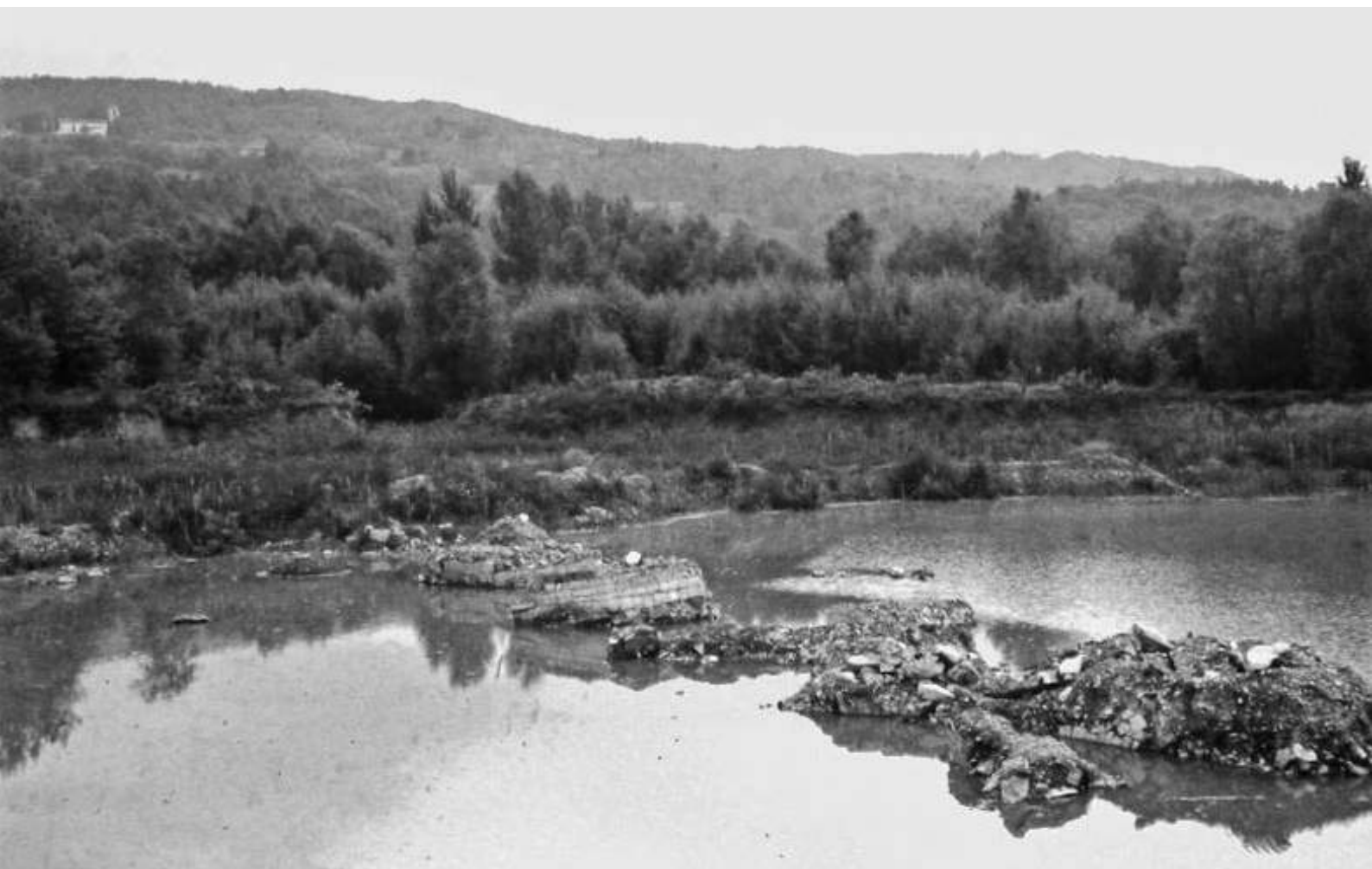
Fig. 39 Resti del ponte del Colombaiotto prima della costruzione del lago (1996)
