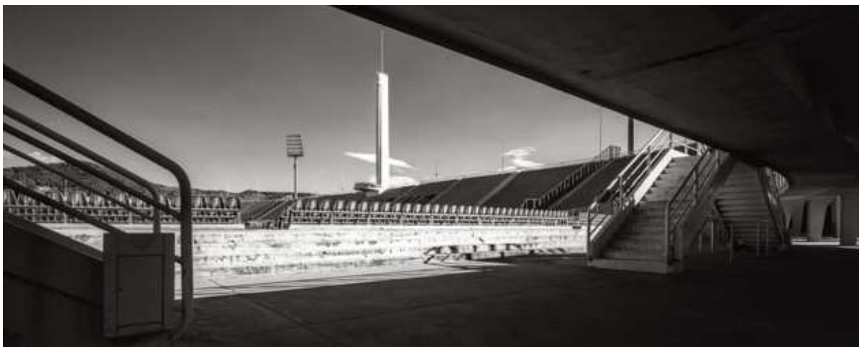
Nella pagina a fianco, l'enfilade di sostegni e nervature in calcestruzzo che sostengono le gradinate dello stadio Artemio Franchi a Firenze. Sopra, scorcio dell'area interna.
