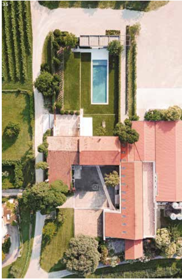
13, 14 il fronte esterno e quello interno del nuovo corpo di fabbri- ca ospitante la piscina 15 veduta aerea del complesso della cantina Gorgo 16, 17 riproduzione delle pagine del quaderno di Filippo Bricolo con i disegni del progetto per la cantina
