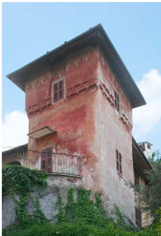
5. La torretta che proteggeva il fianco settentrionale della Porta inferiore (foto Enrico Lusso).
