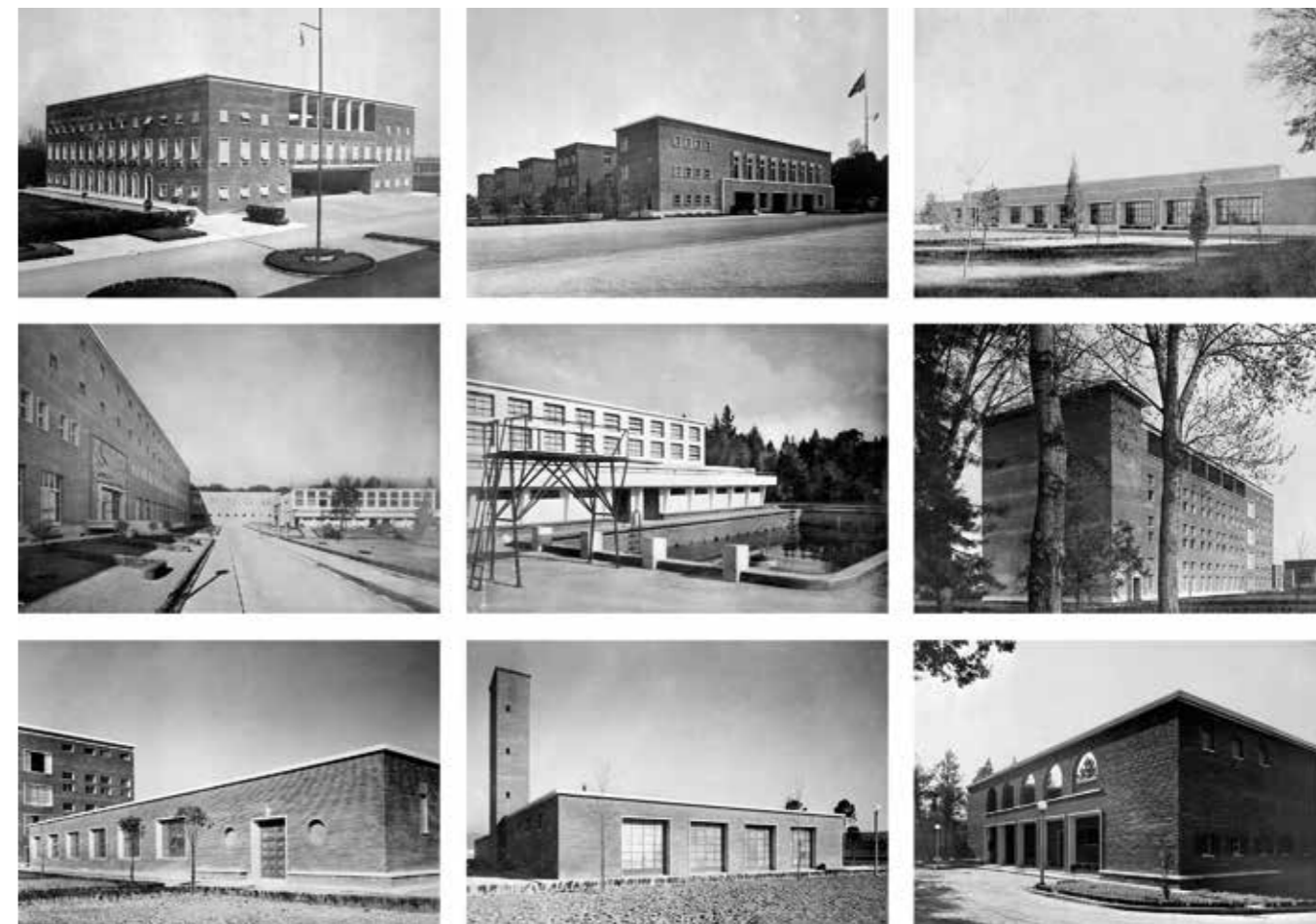
Fig. 4.10 Foto storiche dei principali fabbricati del complesso
