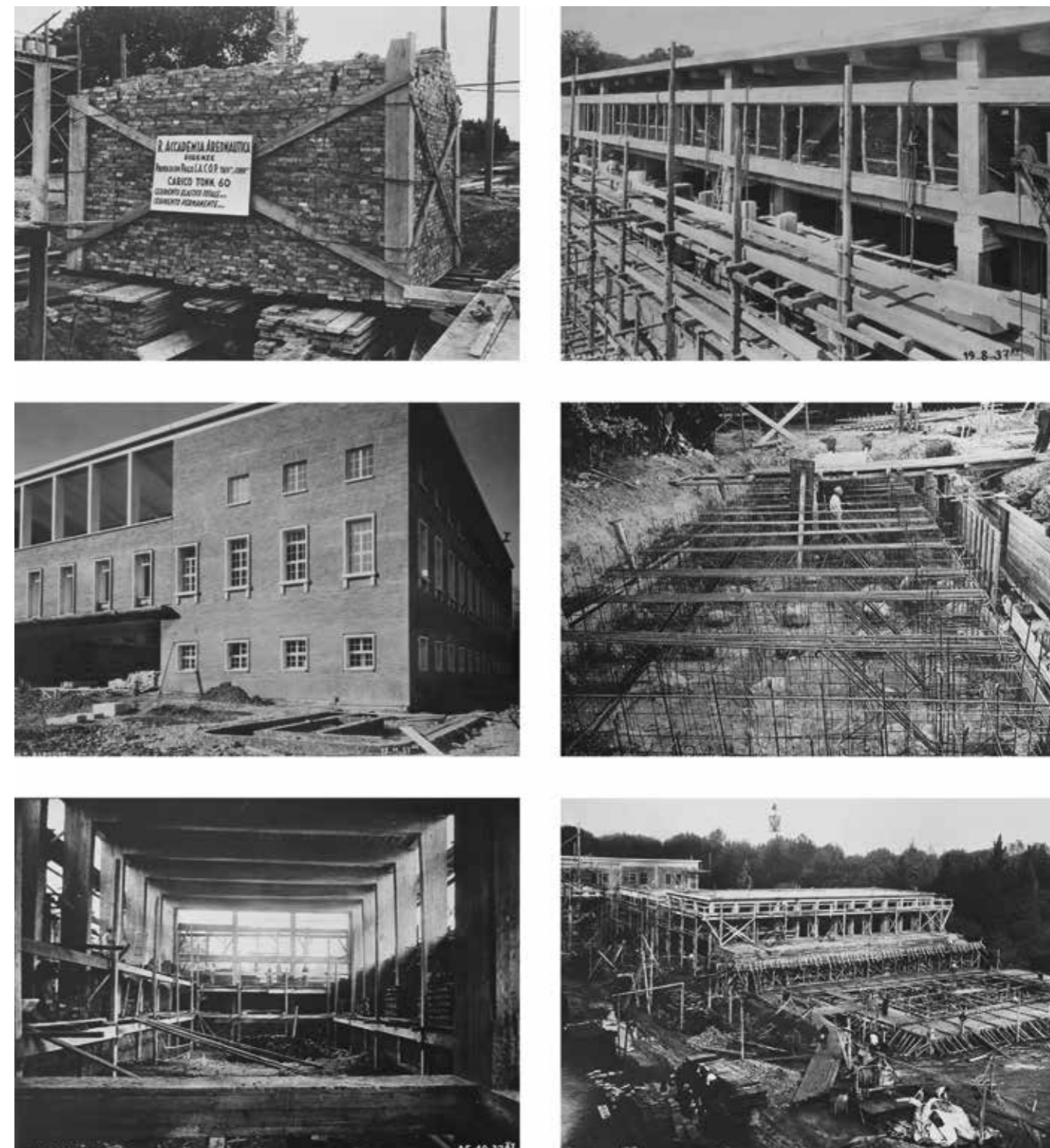
Fig. 4.15 Foto delle attività di cantiere scattate dai fratelli Barsotti in fase di costruzione
