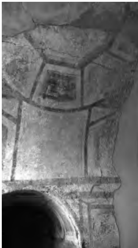
Fig. 12 Milano, S. Aquilino, disassamento del motivo rispetto all'arco
