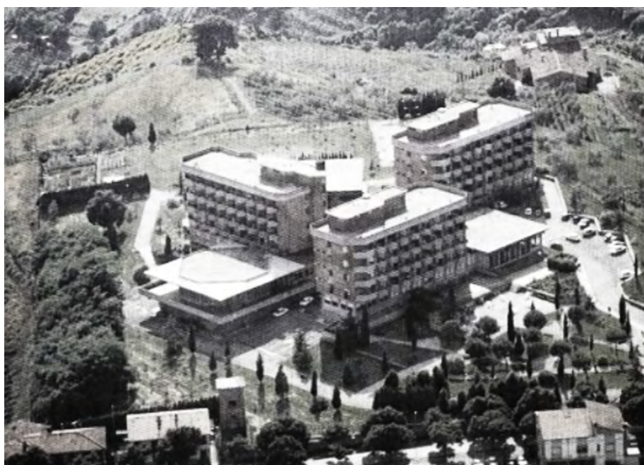
2. Il complesso dell'RSA Villa Serena a Montaione, oggetto di un intervento di recupero
