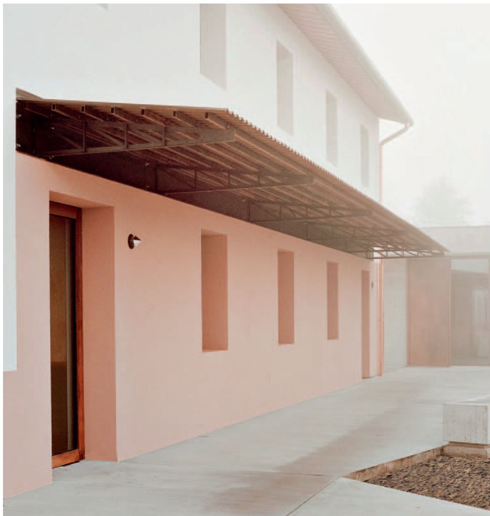
Dettaglio della pensilina recuperata.
