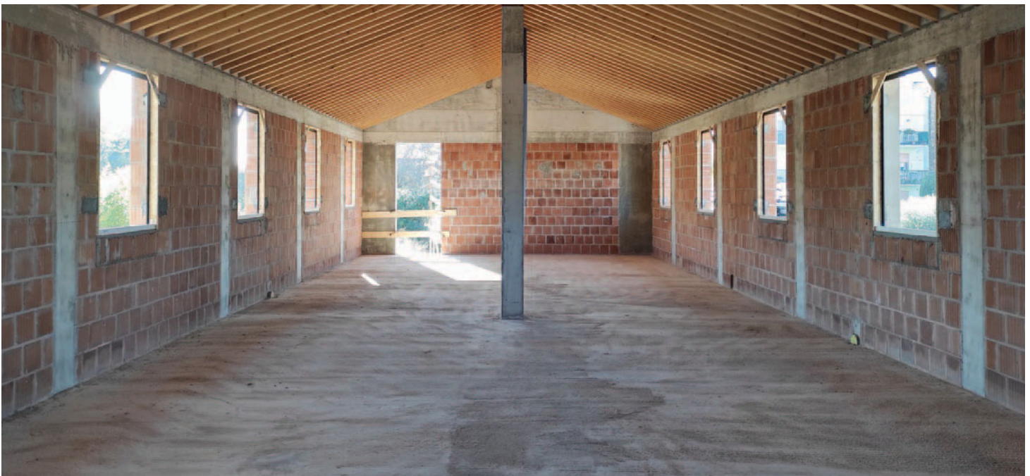
Vista della farmacia durante i lavori.
