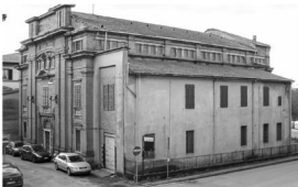
⊕ Il Teatro- cinema prima degli interventi di restauro (2002)
