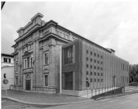
⊕ Vedute dall'esterno del Teatro- cinema dopo gli interventi di restauro
