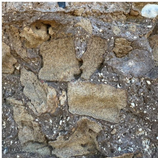
Fig. 2. Torre Testa (BR). Efflorescenze saline sul conglomerato di malta di calce e pietrame calcareo del nucleo interno.
