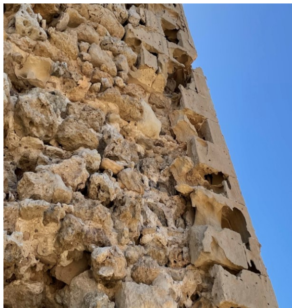
Fig. 3. Torre Zozzoli (TA). Alveolizzazione ed erosione dei blocchi squadrati di calcarenite dei cantonali.
