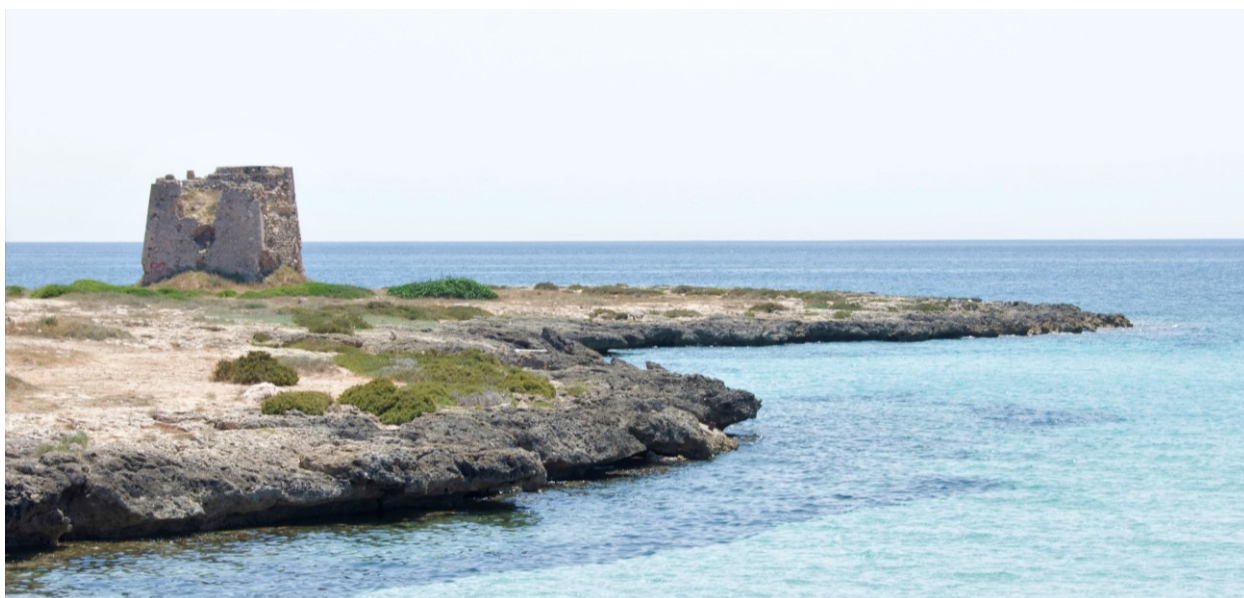
Fig. 1. Torre Zozzoli (TA), veduta generale.
