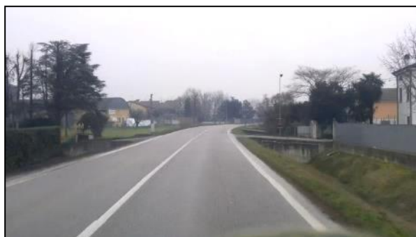
presenza di canali a bordo strada e di accessi laterali
