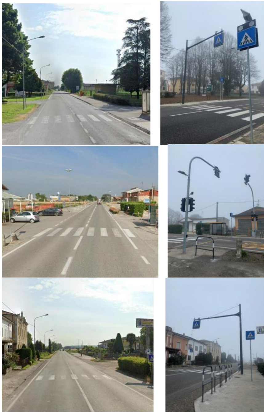
Figura 6.16 - Interventi di miglioramento degli attraversamenti pedonali conseguenti alle ispezioni di sicurezza stradale
