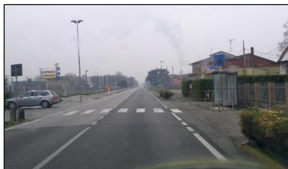
attraversamento pedonale in tratta extraurbana
