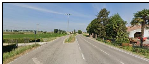
manovre di immissione ad alto rischio lungo la SPesSS 482 e presenza di accessi privati
