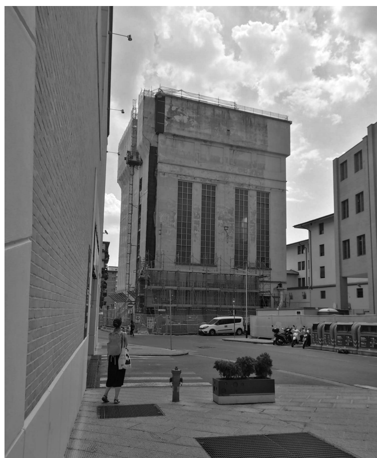
Fig. 6 – L'unica struttura sopravvissuta, nel paesaggio urbano contemporaneo, dell'imponente impianto FIAT di Novoli: la centrale termica detta "torre FIAT".
