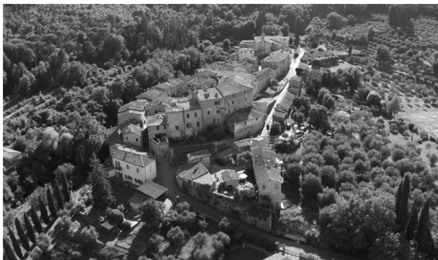
Torri dall'alto. Fotografia aerea Marco Corridori
