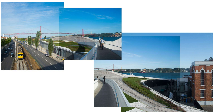
Fig. 2 - La centrale elettrica di Junqueira (a destra) è riconvertita a museo dell'elettricità nel 1990. Nel 2017, in occasione dell'inaugurazione di un secondo edificio museale (a sinistra), lo spazio pubblico tra i due è rimodellato e collegato con un ponte pedonale ai quartieri di Ajuda e Belém.
