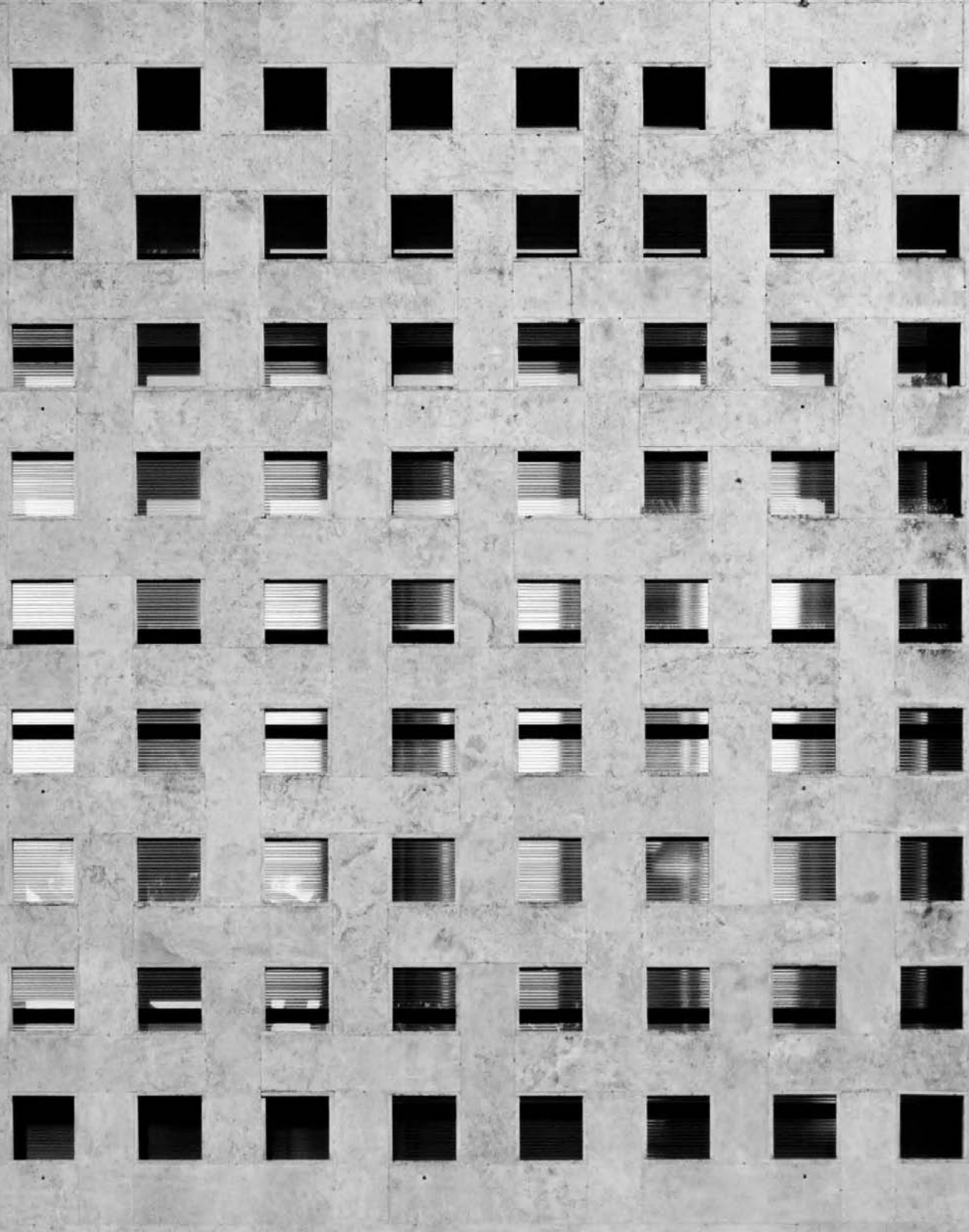
Dettaglio delle aperture, facciata posteriore, Palazzo delle Poste, Roma.
