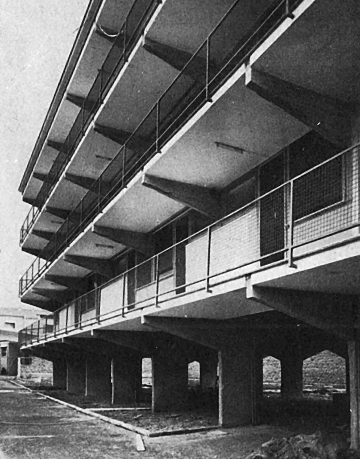
Dettaglio dell'edificio a ballatoio, Tuscolano, 1952.
