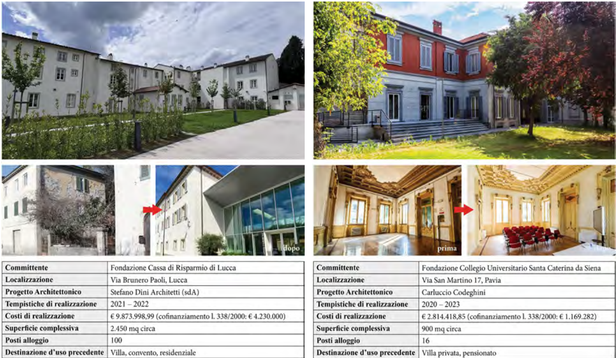
Figg. 5, 6 - A sinistra, residenza di Via Brunero Paoli, Lucca. Foto e dati: Archivio Centro TESIS. A destra, residenza Villa Necchi, Pavia. Foto: Antonio La Valle - Dati: Archivio Centro TESIS.
