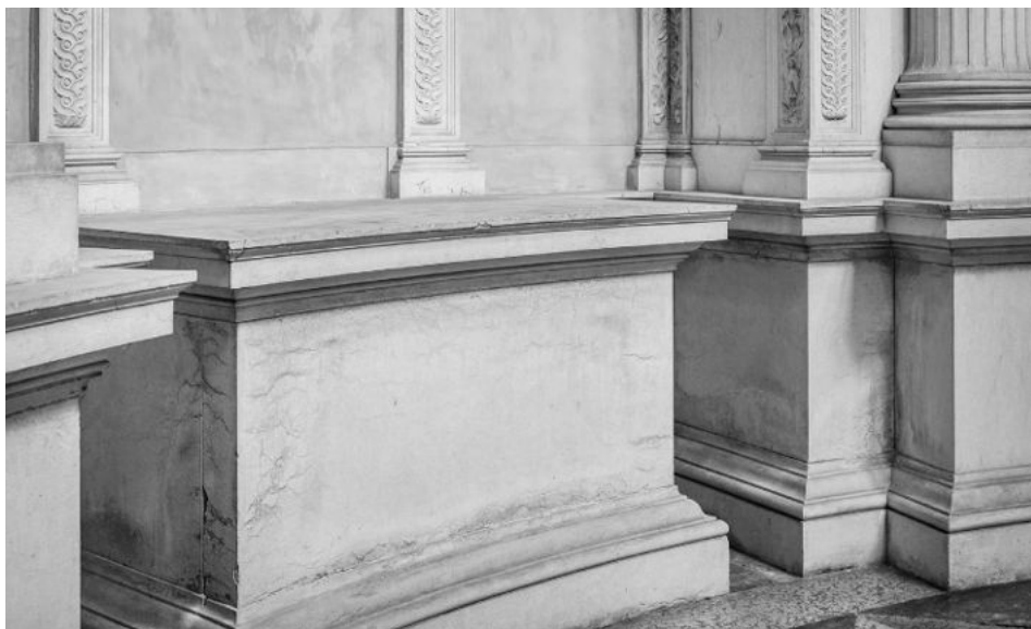
Fig. 3 - Verona, Chiesa di S. Bernardino, Cappella Pellegrini. Dettaglio del basamento interno.
