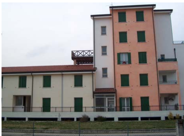
Figura 4. Vista frontale dei due edifici esaminati
